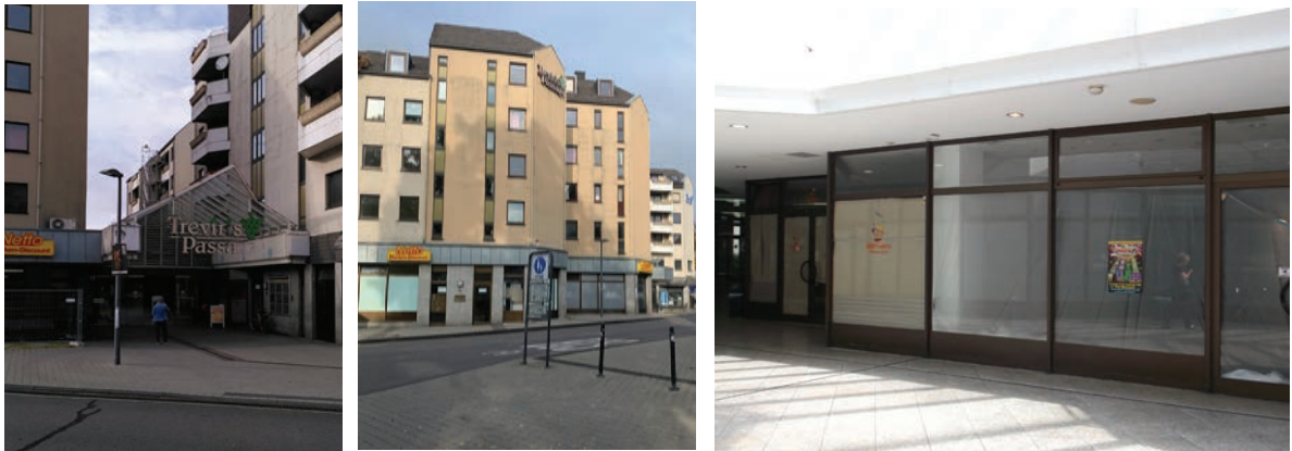
Abb. 27 : Treviris- Passage mit hoher Leerstandsquote und Sanierungsbedarf
