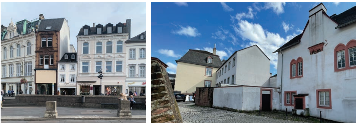
Abb. 26 : Umfeld Porta- Nigra; Gebäude mit Sanierungsbedarf
