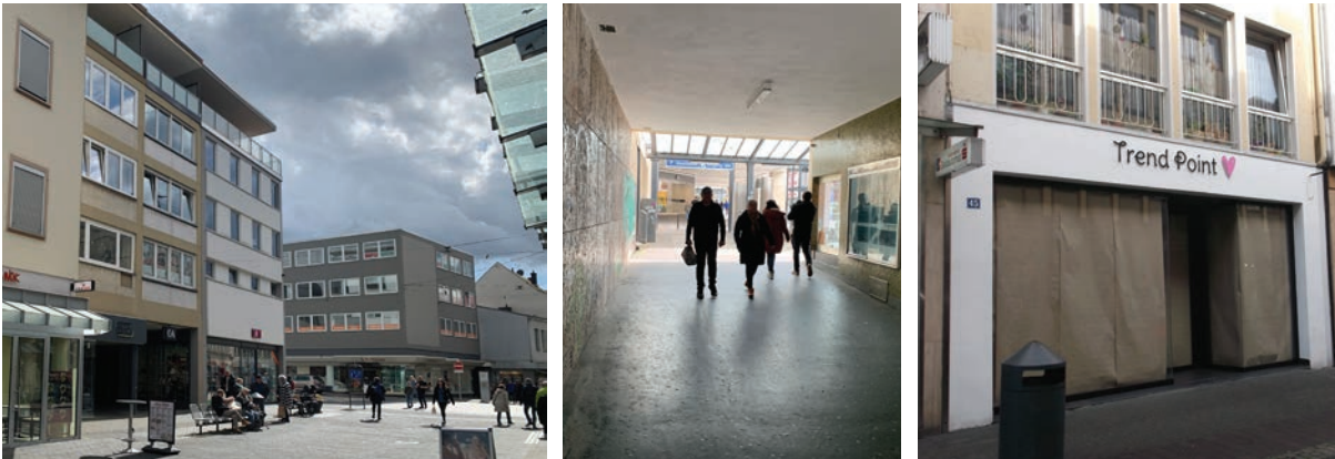
Abb. 30 : Brotstraße mit Ecksituation Kontantinstraße; Sanierungsbedarfe
