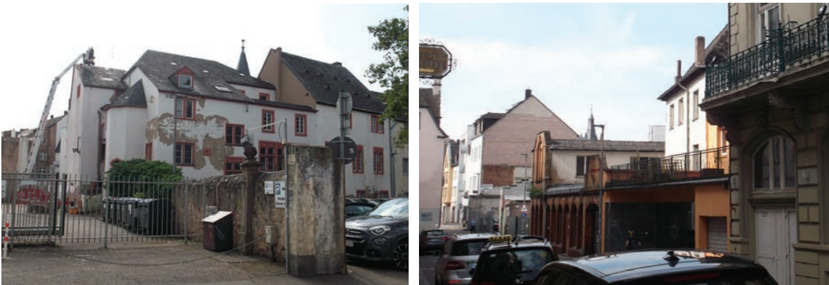
Abb. 25 : Umfeld Rindertanzplatz; Gebäude mit Sanierungsbedarf
