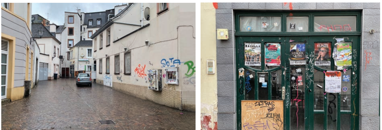
Abb. 29 : Judengasse und Randbebauung in insgesamt schlechtem Zustand
