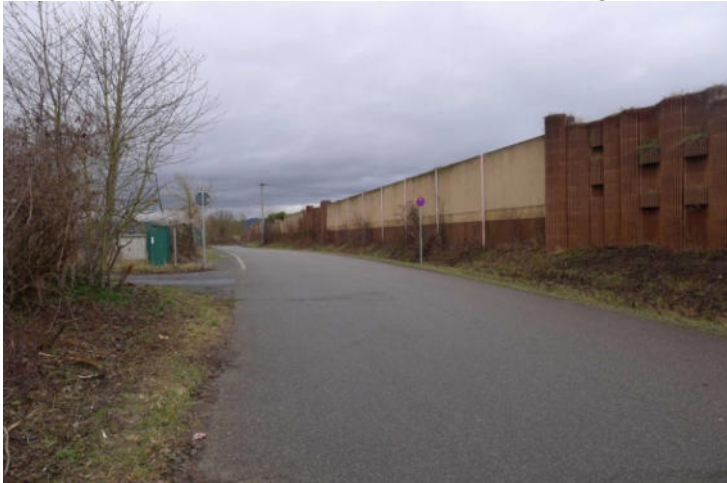
Abbildung 27: Lärmschutzwand zwischen „Stierweg“ und B 256
