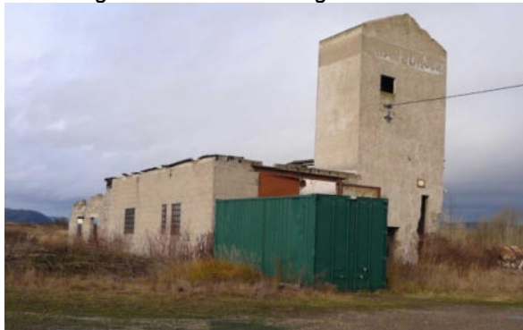
Abbildung 8: ehem. Betriebsgebäude im Süden des Plangebiets
