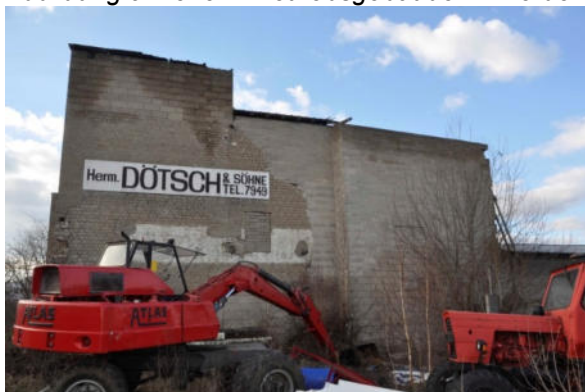
Abbildung 9: ehem. Betriebsgebäude im Norden des Plangebiets
