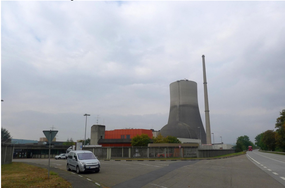
Abbildung 6: Blick auf das Gelände vom Zufahrtsbereich/ Anbindung an K 44 Bildhintergrund: Kühlturm mit Abbruchroboter
