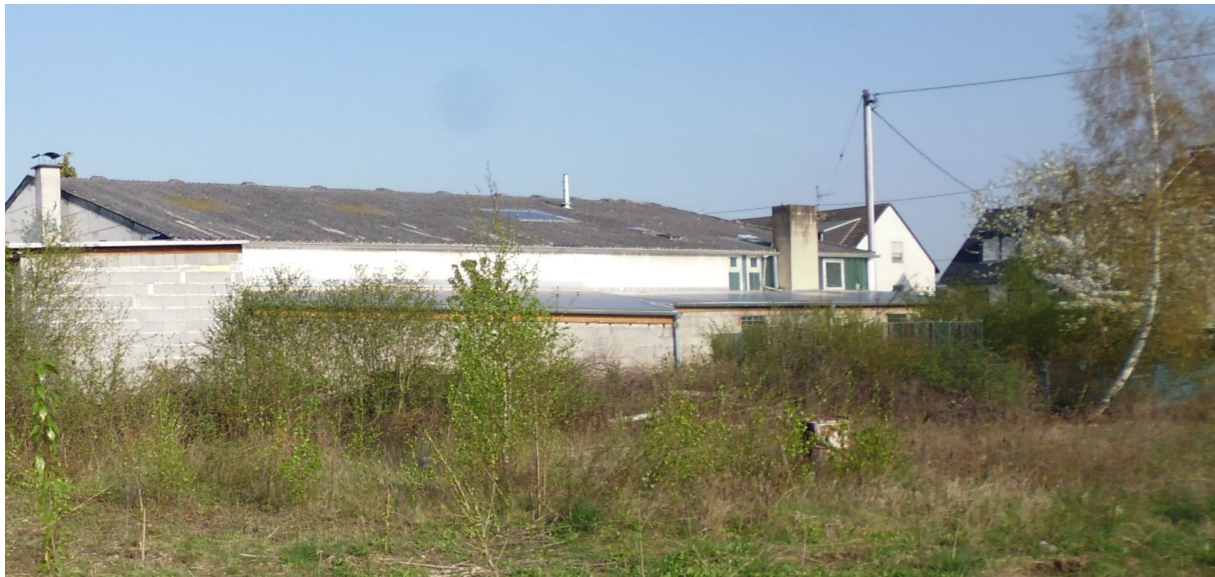
Foto 1: Ostseite Werkstattgebäude Kfz-Betrieb
