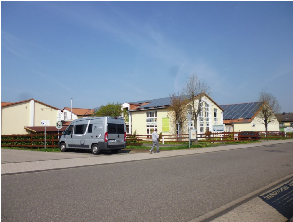
Foto 8: Betriebsgebäude Sport- und Freizeitanlage
