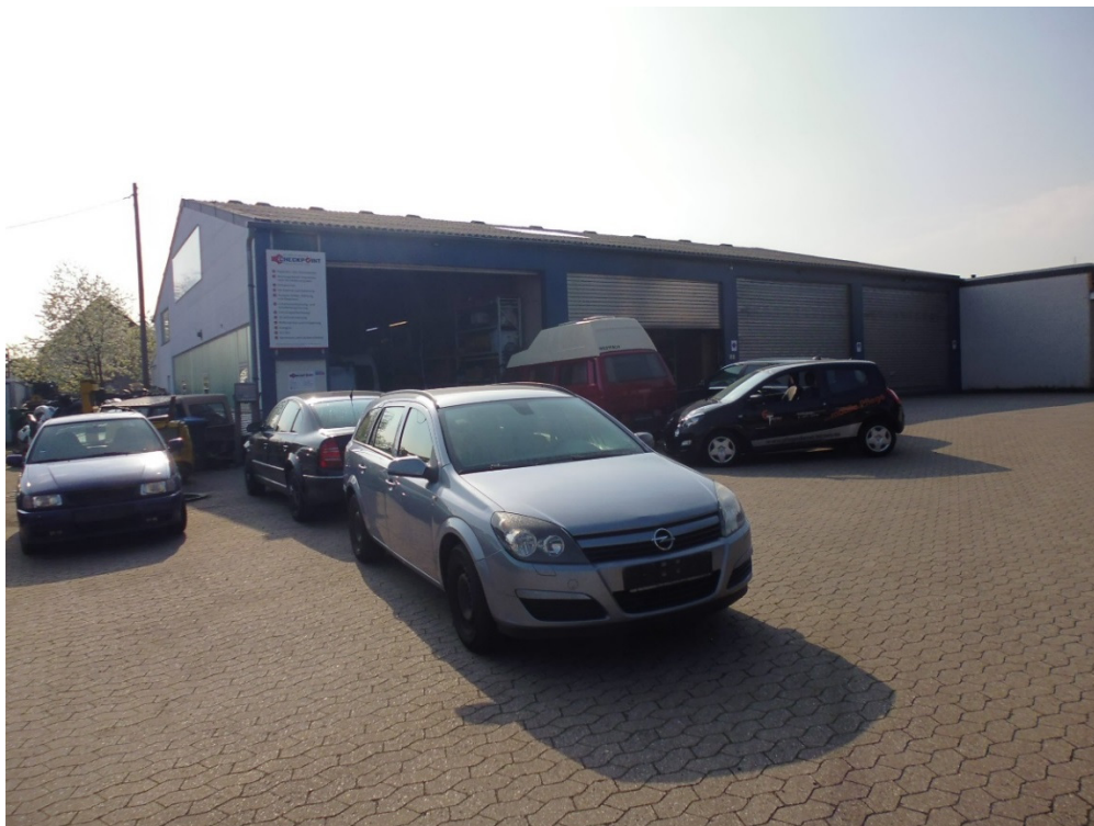
Foto 3: Wagenhalle Busbetrieb (zwei rechte Tore)
