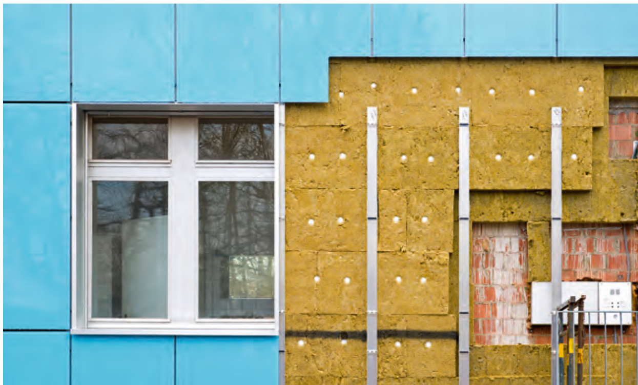
Hinterlüftete Fassadenkonstruktion
