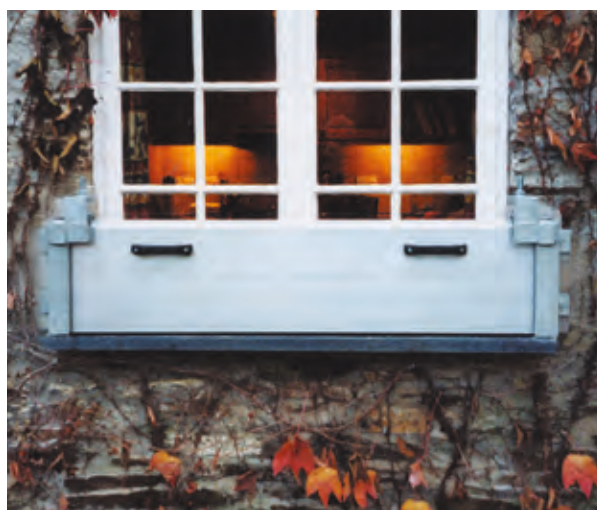
Hochwasserschutz an Fensteröffnungen
