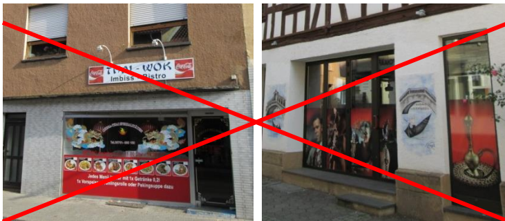
Großflächig dauerhaft beklebte Fensterflächen wirken negativ im historischen Stadtbild
