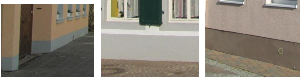
Verputzte Sockel, farblich abgesetzt
