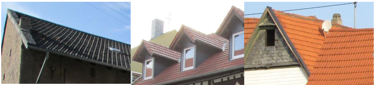
Braune, rotbraune bis rote Dacheindeckungen und .....
