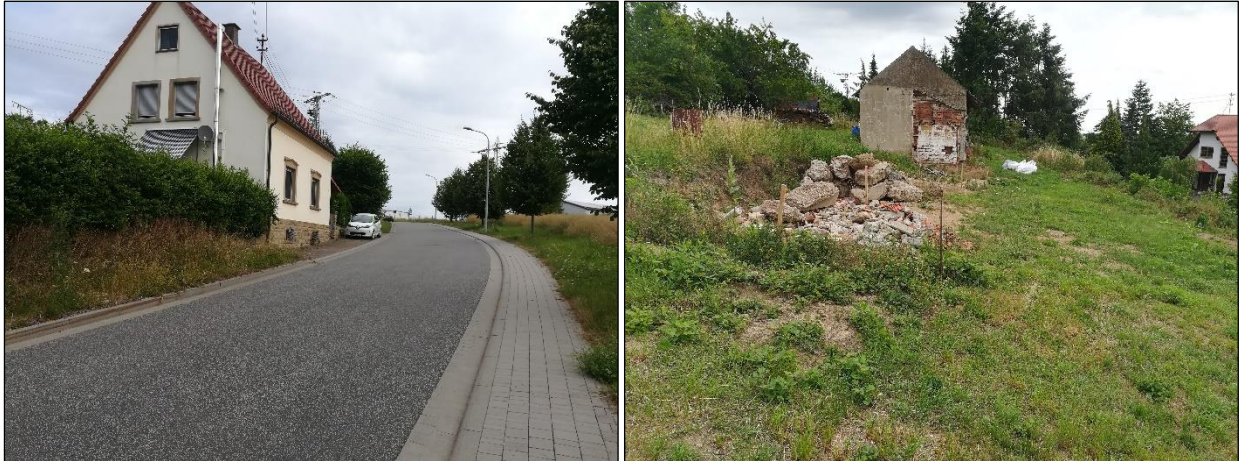
Abbildung 2: Blick nach Norden entlang der Straße „Oberdorf“ auf die Bestandsbebauung (Foto links; Blick auf Flurstück 3894/1 und teilweise bereits abgebrochenen Gebäudebestand bzw. den vorhandenen Schuppen (Foto rechts) des Flurstücks 3894/3
