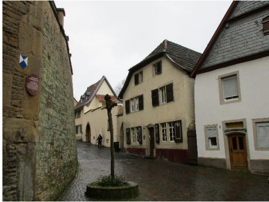
Krüppelwalmdach aus Tonziegeln in der Amtsgasse (Quelle: WSW & Partner)
