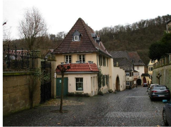
Walmdach aus Tonziegeln in der Amtsgasse (Quelle: WSW & Partner)
