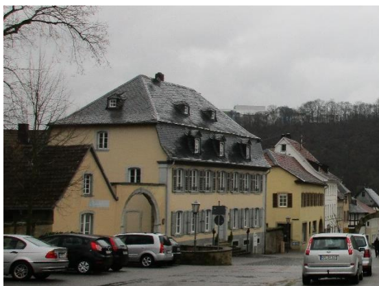
Mansarddach aus Schiefer in der Amtsgasse (Quelle: WSW & Partner)
