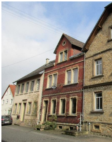
Beispiel eines Zwerchgiebels in der Schillerstraße (Quelle: WSW & Partner)
