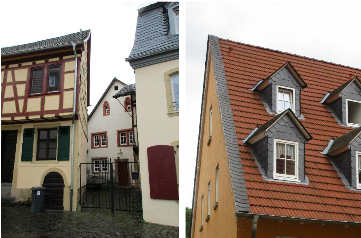
Regenfallrohre aus Zinkblech an einem historischen Gebäude in der Obergasse (links) und ein Beispiel für die Gestaltung des Ortgangs mit Schiefer (rechts) (Quelle: WSW & Partner)
