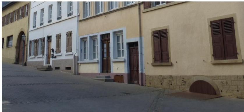
Unterschiedliche Sockel in der Amtsgasse; deutlich vom Rest der Fassade abgrenzbar (Quelle: WSW & Partner)
