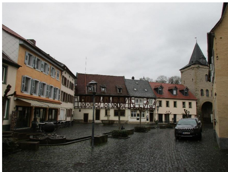
Geschlossenes Gebäudeensemble am Klenkertor (Quelle: WSW & Partner)
