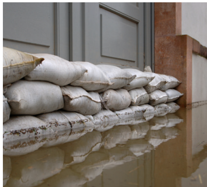
Notfallmäßiger Objektschutz mit Sandsäcken
