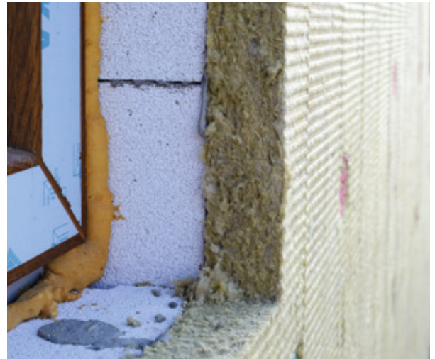
Einsatz von Mineralfaserplatten als Außenwanddämmung
