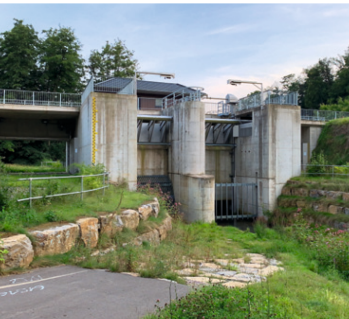
Verschlussbauwerk eines Hochwasserrückhaltebeckens
