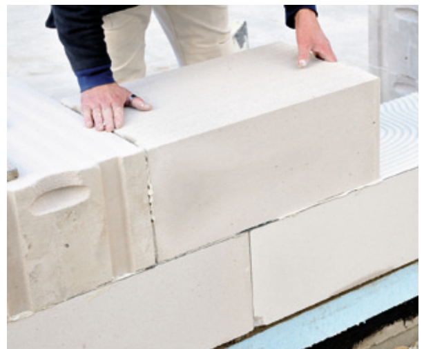
Mauerwerk aus Porenbeton-Plansteinen
