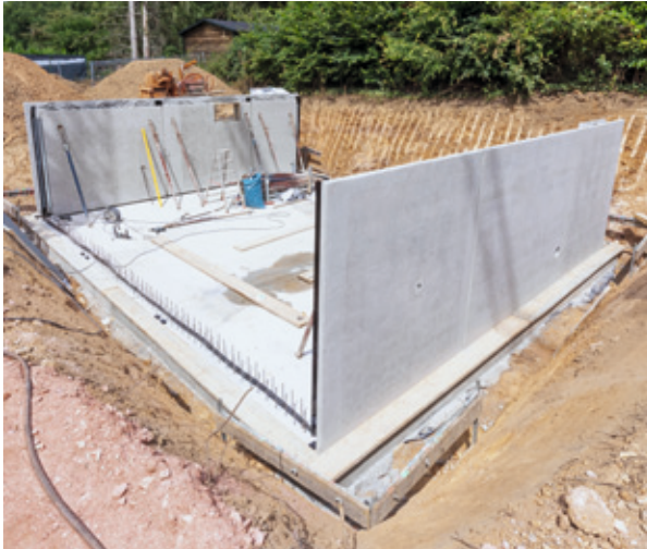
Keller in WU-Bauweise
