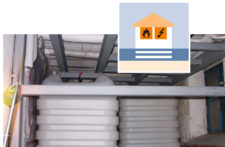
Anpassen: zum Beispiel durch Sicherung bestehender Tankanlagen
