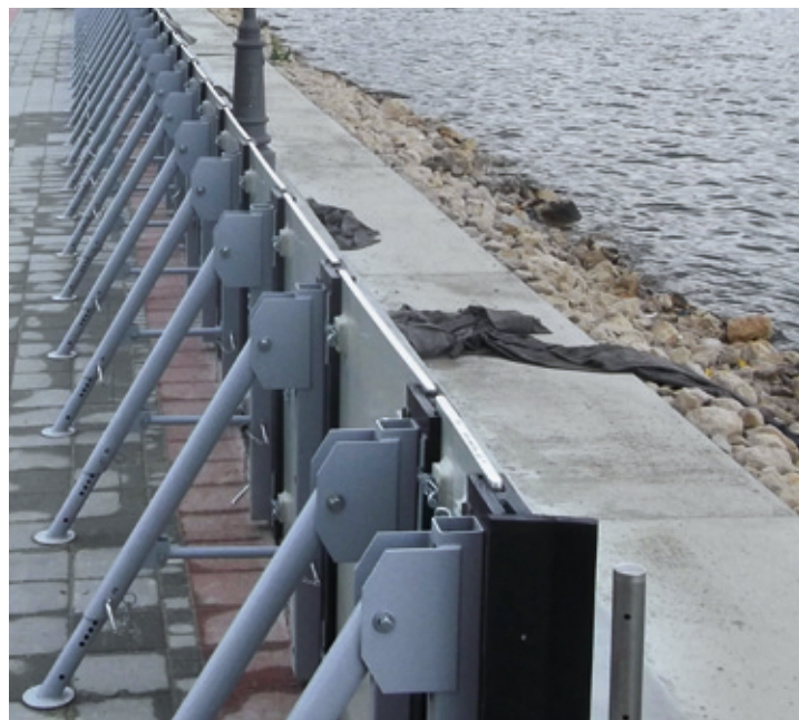
Hochwasserschutz mit Hochwasserschutzplatten aus Kunststoff
