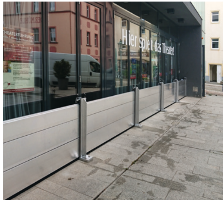
Objektschutz mit teilmobilen Schutzelementen
