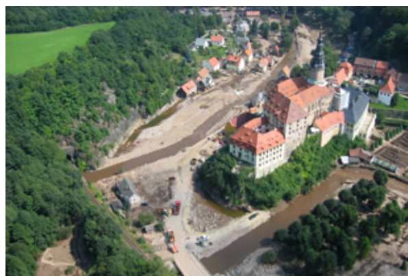
Hochwasserschäden 2002 in Weesenstein an der Müglitz ...
