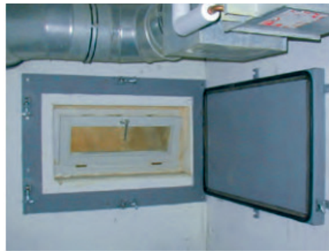
Abbildung 9 Druckdichtes, selbstschließendes Fenster (BMUB, 2016)
