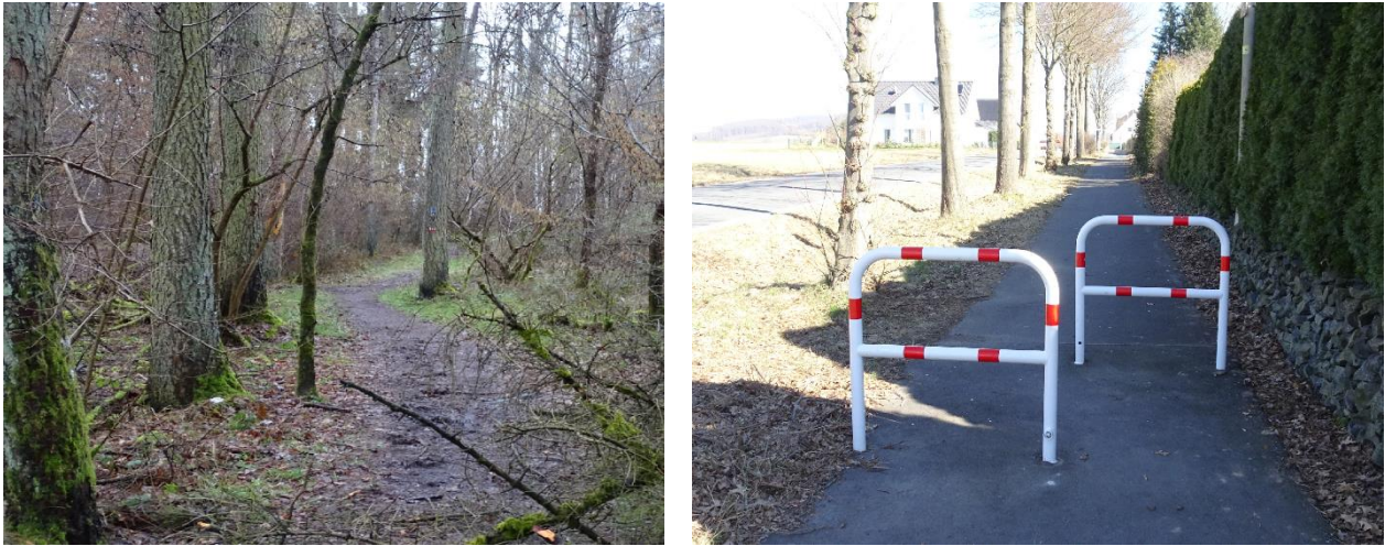
Abbildung 36: Gefahrenpunkte auf der Strecke: Umlaufsperrung (links) und Weg mit Ausbaubedarf (rechts)
