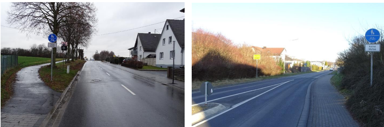
Abbildung 26: Gesicherte Radverkehrsführung: Straßenbegleitender gemeinsamer Geh- und Radweg
