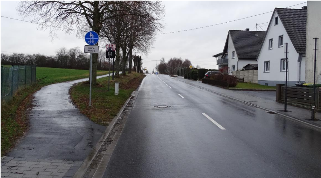
Abbildung 37: fehlende Querungshilfe (Kreisstraße 145)
