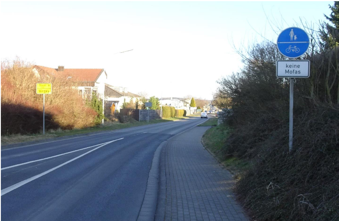
Abbildung 41: Fehlende Kennzeichnung eines Zweirichtungsradweges
