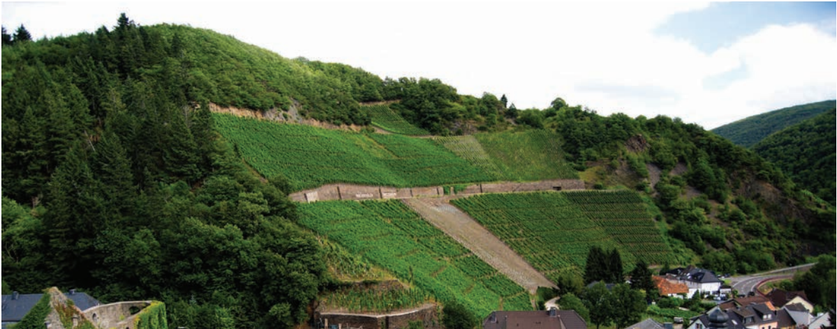
Abb. 3.8/8a: Blick vom Kloster Marienthal auf die Weinbergslage „Trotzenberg“ mit verbuschten Schieferschotterflächen im Osten. Foto: W. Büchs, Braunschweig
