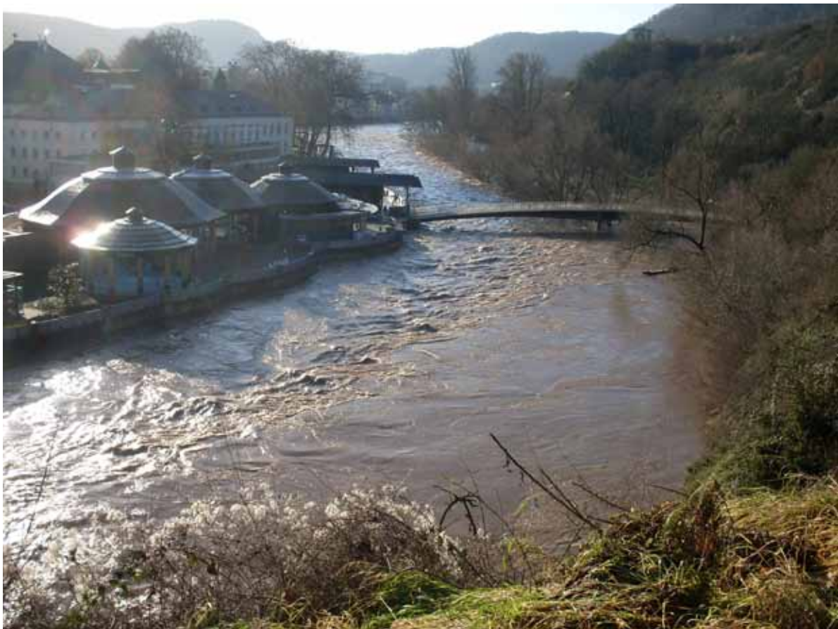
Abb. 58: Die Hochwasser führende Nahe bei Bad Kreuznach im Januar 2011
