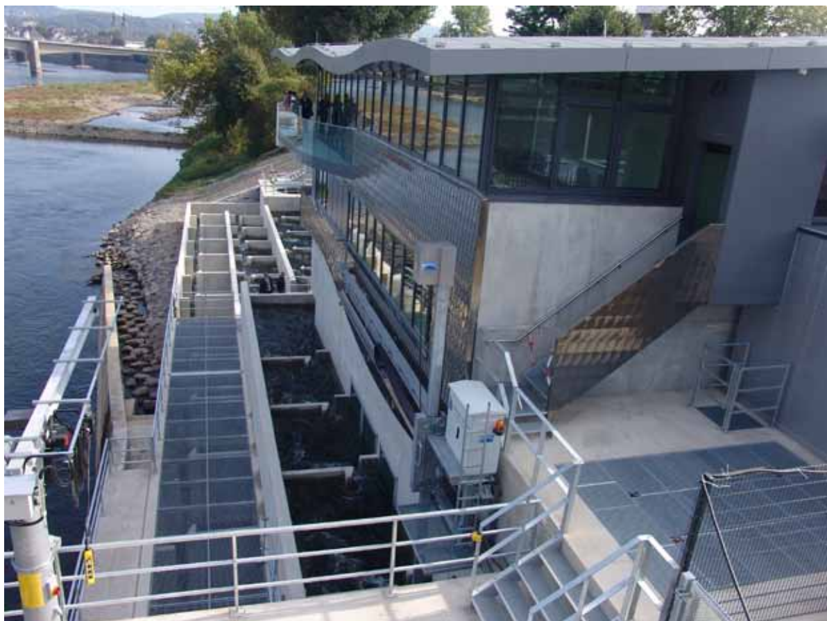
Abb. 44: Blick von der Stauanlage auf den neuen Fischpass und das „Mosellum“. Gut zu erkennen ist die umlaufende Plattform im Obergeschoß, von der aus der gesamte Fischpass eingesehen werden kann.
