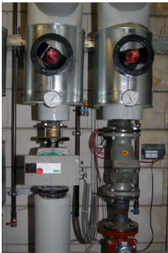
Abb. 21: Fernwärmeanschluss im Wasserlabor
