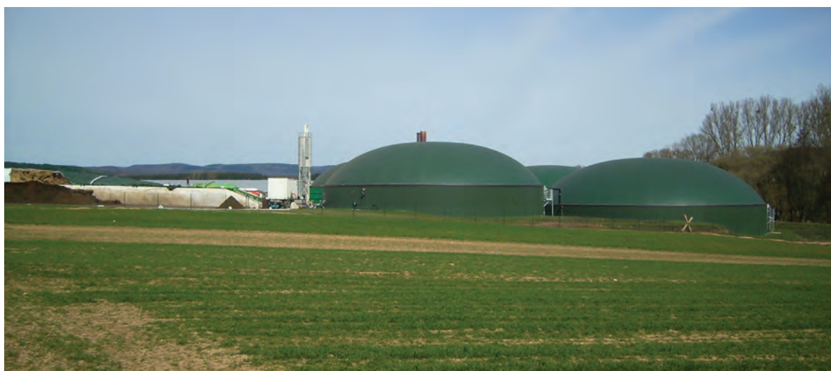
Abb. 54: Beispiel einer Biogasanlage mit Teilen eines Fahrsilos links im Bild
