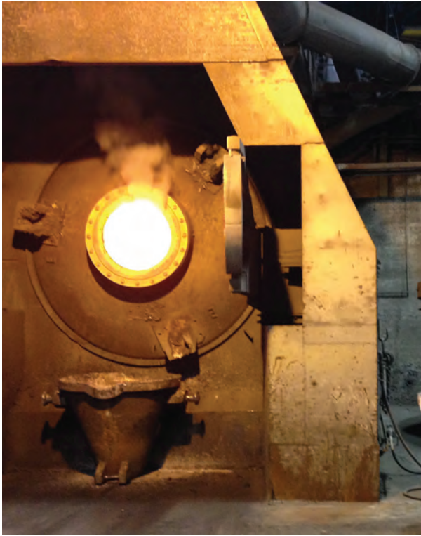
Abb. 7: Energieeinsparungen im Gesamthaushalt durch effiziente Nutzung der Wärmeströme des Bleischmelzofens
