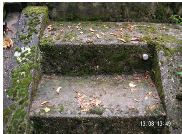
Abb. 73: Höhenbolzen (Pegelfestpunkt) in Treppstufe Pegel Herxheim / Klingbach
