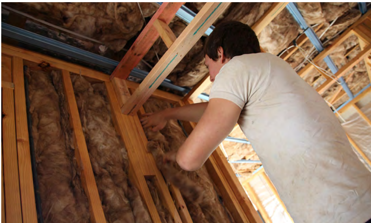
Anbringen von Wandisolierung.
