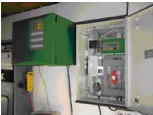
Abb. 3: Redundante Datenspeicherung am Pegel Martinstein/Nahe
