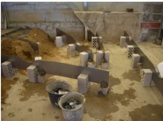
Abb. 62: Einbau der aus Blech geschnittenen Gewässer- und Geländeprofile
