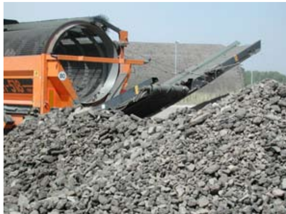
Abb. 43: Aufbereitung von Straßenaufbruch
