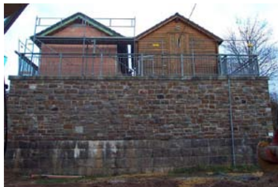
Abb. 146: Rohbau Station (Hinteransicht; Blick vom Ufer der Nahe)
