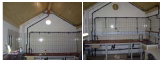
Abb. 151, 152: Verkleidete Deckenkonstruktion und Messwasserleitung mit Abgängen (während der Bauphase)
