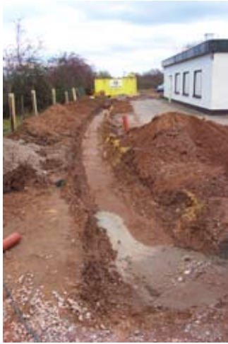
Abb. 148: Graben für Trink- und Abwasser
