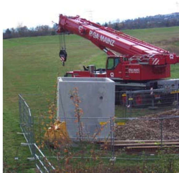
Abb. 161: Pumpenschacht
