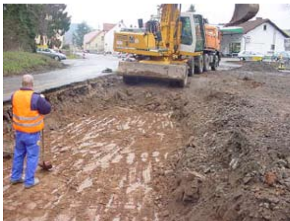
Abb. 34: Rückbau einer Straße
