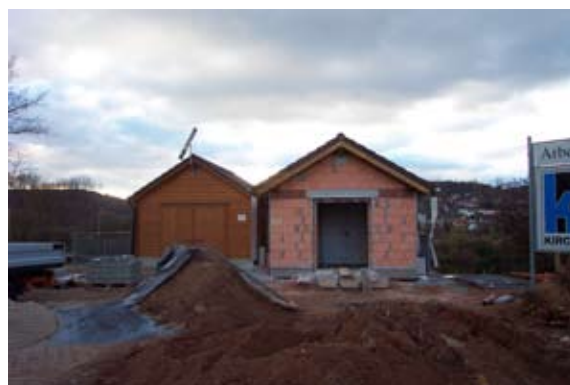
Abb. 147: Rohbau Station (Vorderansicht)
