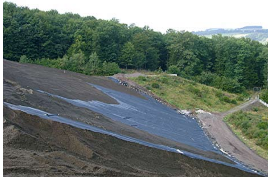
Abb. 44: Aufbringen der mineralischen Flächendrainage auf der Kunststoffdichtungsbahn bei der Deponie Reibertsbach (Foto K.Brand)
