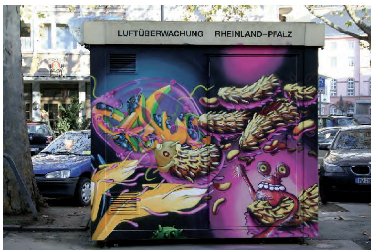
Abb. 8 Messstation Mainz-Große Langgasse
