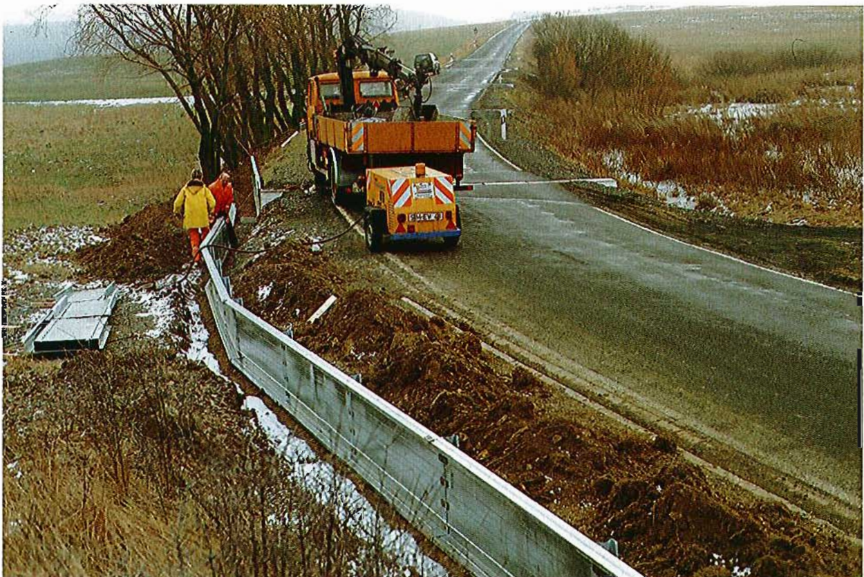
Foto 130. Installation einer Amphibienleitanlage (Foto: M. BRAUN).-
