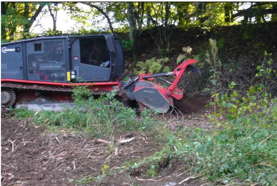
Einsatz eines Forstmulchers beim Freischneiden der Zauntrasse
