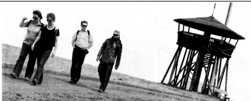
Der 30 Jahre alte Aussichtsturm hoch über dem Meerfelder Maar ist baufällig. Er soll noch in diesem Jahr durch einen Neubau ersetzt werden. Foto: Ursula Quicker
