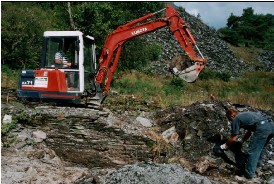
Mauersanierungs-Projekt (2000-2005) – Baggerarbeiten auf der Herrenwiese
