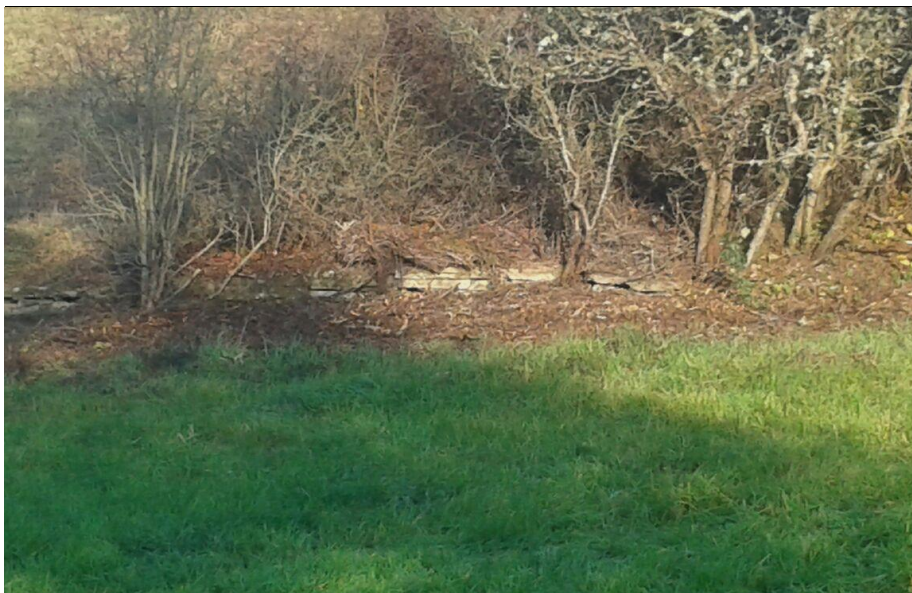
Detailaufnahme der freigestellten Mauer.
