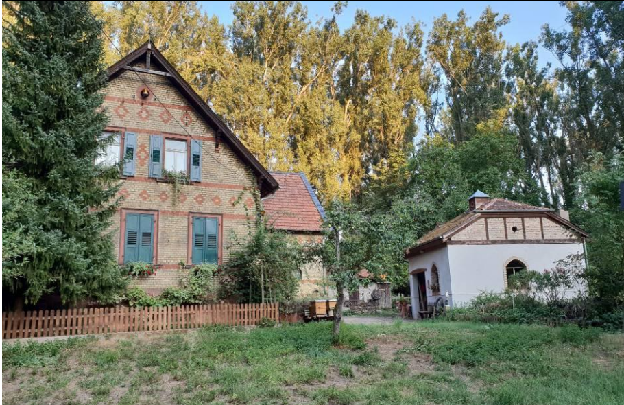
Das alte denkmalgeschützte Stromwärterhaus auf Kisselwörth
