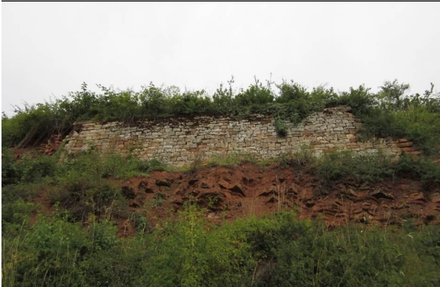
Zugewachsene, teilweise wieder freigestellte Weinbergsmauer
