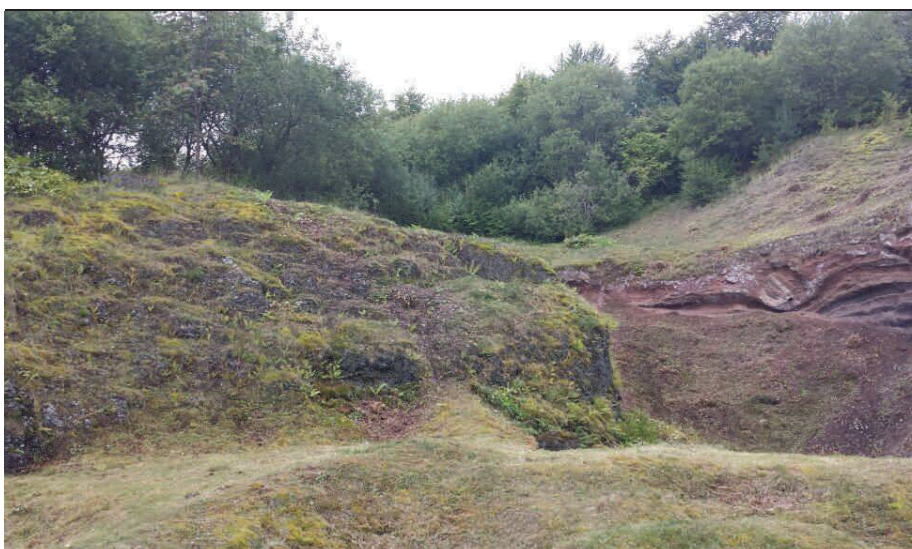
Motormanuell freigestellte Böschungen in der Abgrabung am Schneeberg.
