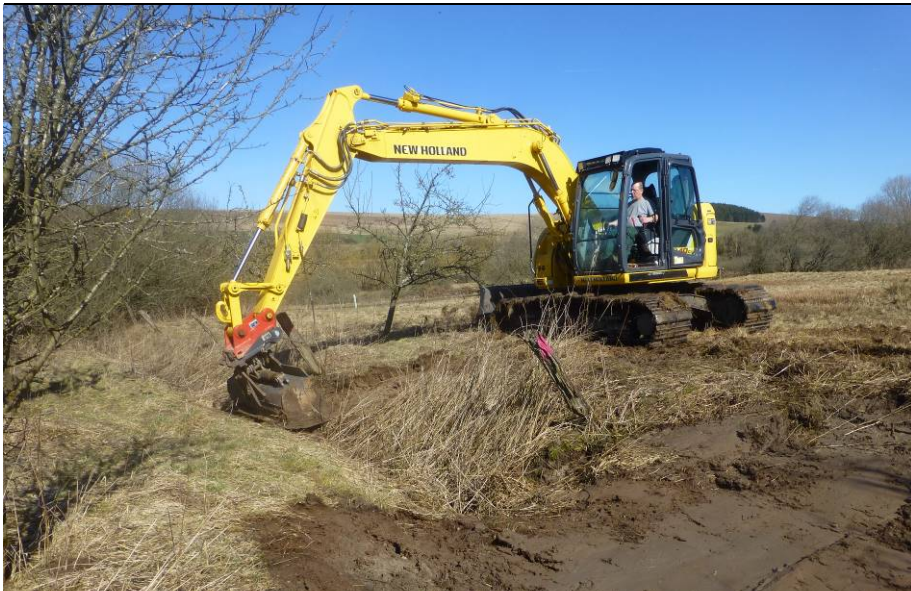
Verschließen von Entwässerungsgräben.
