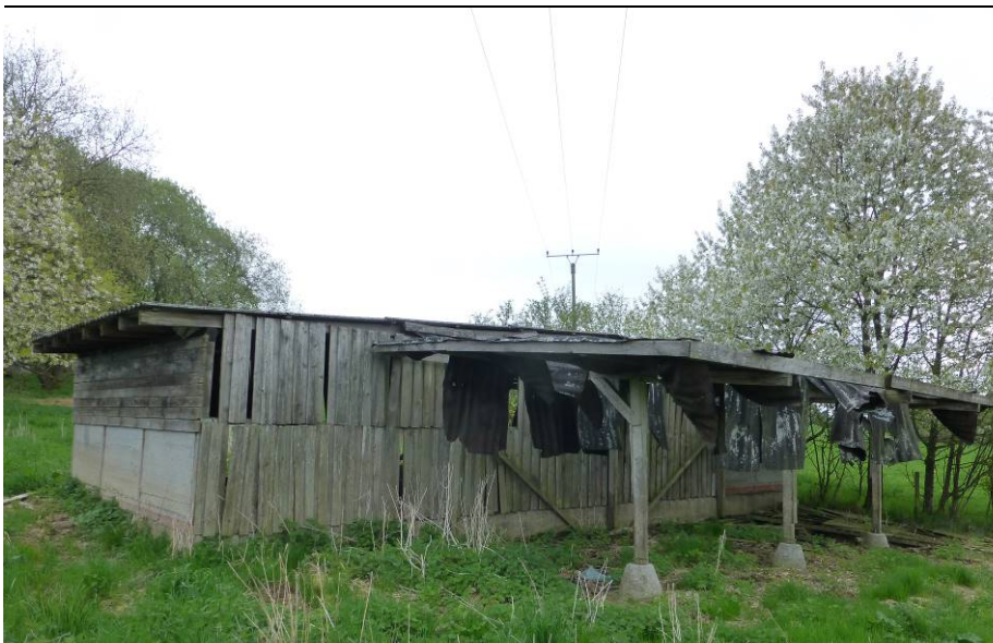
Größerer Viehunterstand mit Betonfundamenten und Eternitplattenab- deckung, der im Frühjahr 2017 vom NABU beseitigt wurde
