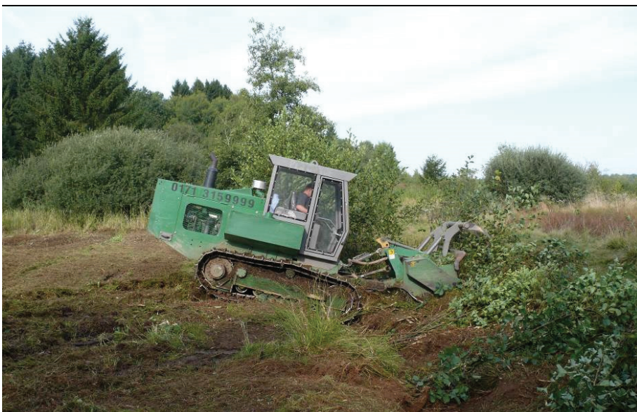
Entbuschung der Verlandungszone mit Mulchraupe
