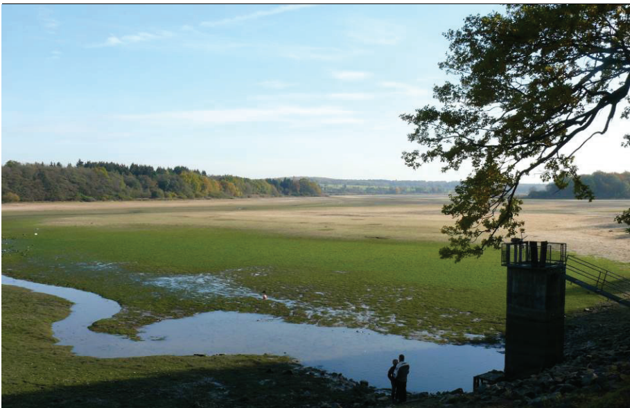
Abgelassener Weiher mit Schlammböden und Verlauf der Wied vorm Damm
