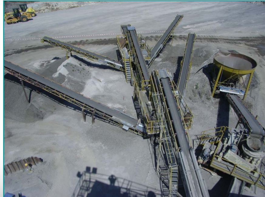
Blick von der Siebanlage:
