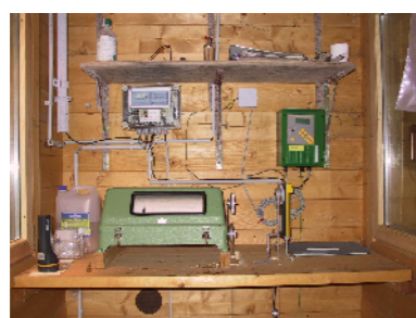
Innenansstattung eines Pegelhauses
