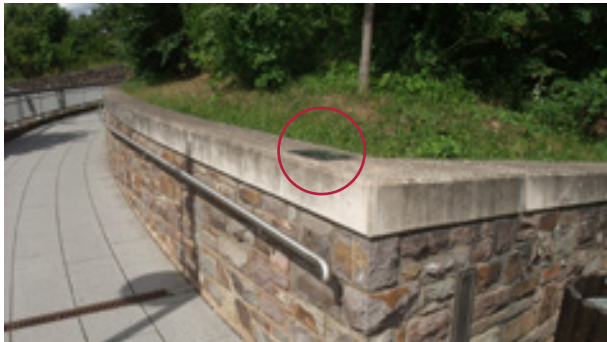
GPS-Vergleichspunkt auf der bergseitigen Mauer des Verbindungsweges vom Parkplatz am Feuerwehrgerätehaus zur Bahnunterführung in Bullay.
