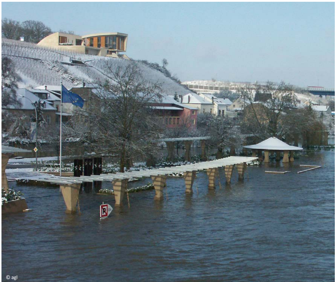
Hochwasser an der neuen Uferpromenade von Schengen (Dezember 2010)
