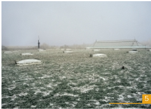
Dachbegrünung auf dem Baumarkt zur Rückhaltung von Niederschlagswasser
