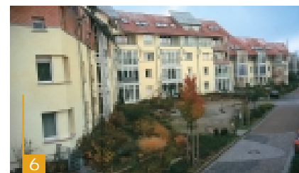
Überblick über die Wohnanlage. entlang der Gebäudefront verläuft der Filtergraben, in den die Dachflächenwässer eingeleitet werden.
