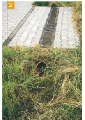
Detail einer Grundstückszufahrt
