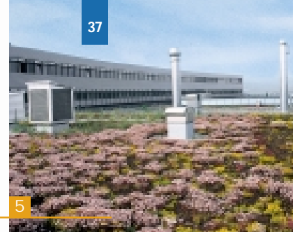
Die Dachbegrünung des Gebäudes hält einen Großteil des Niederschlagswassers zurück.
