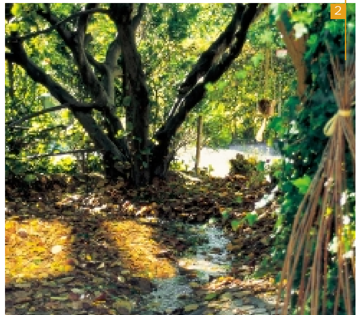
Zulauf vom Regenfallrohr zur Versickerungsmulde unter dem Baum
