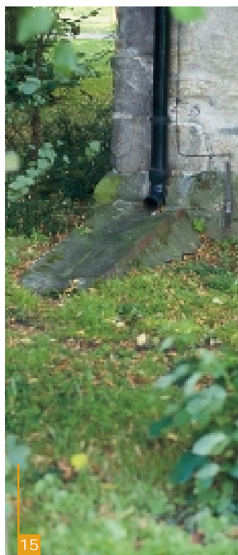
Übergang Fallrohr – Gelände
