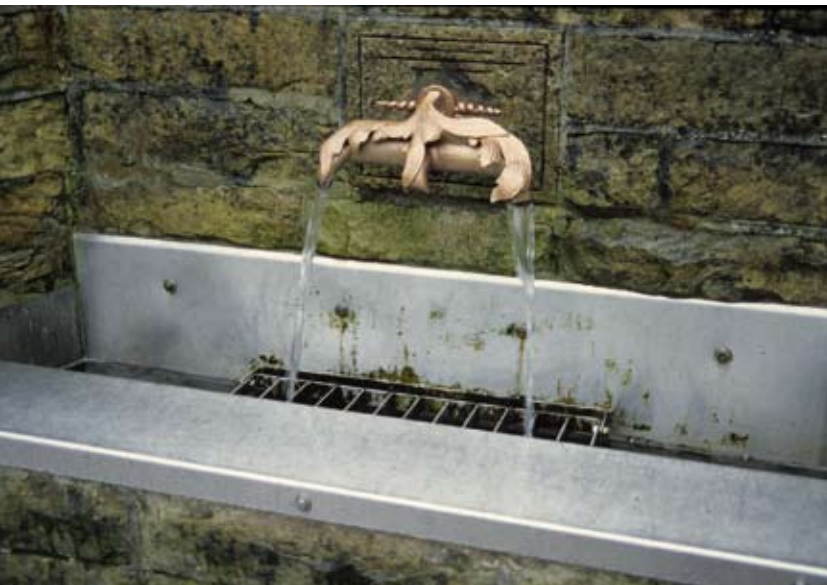
Auch heute noch werden Quelfassungen immer wieder erneuert.
