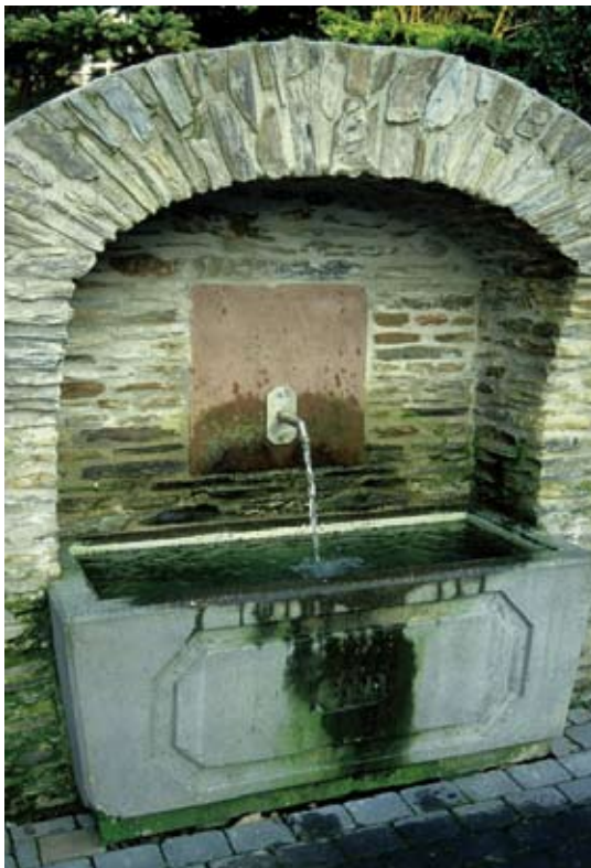
Typen von Quellfassungen: Quellfassungen mit Rohr und Becken.
