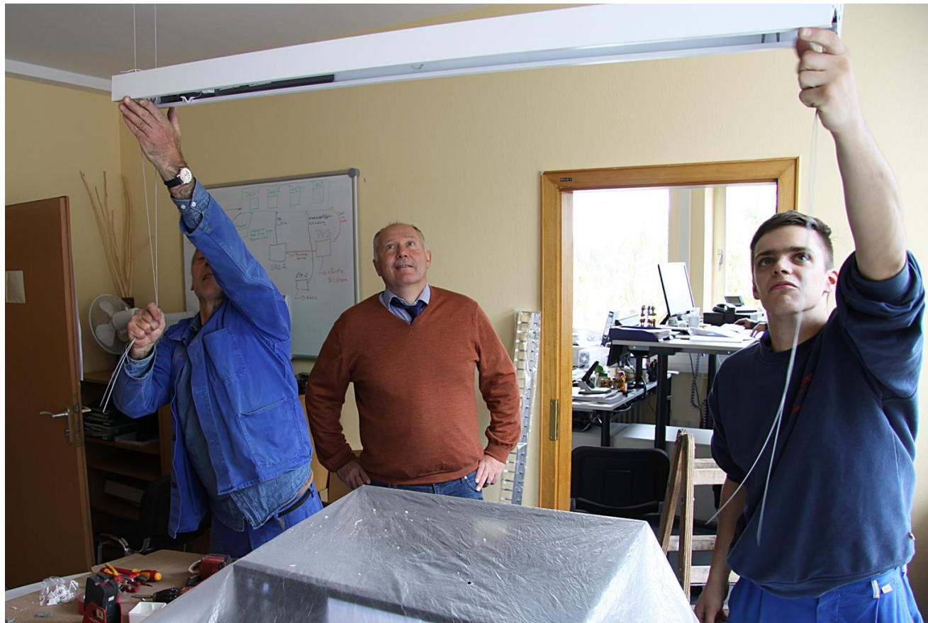
Tausch der Innenraumbeleuchtung im Rathaus Birkenfeld
