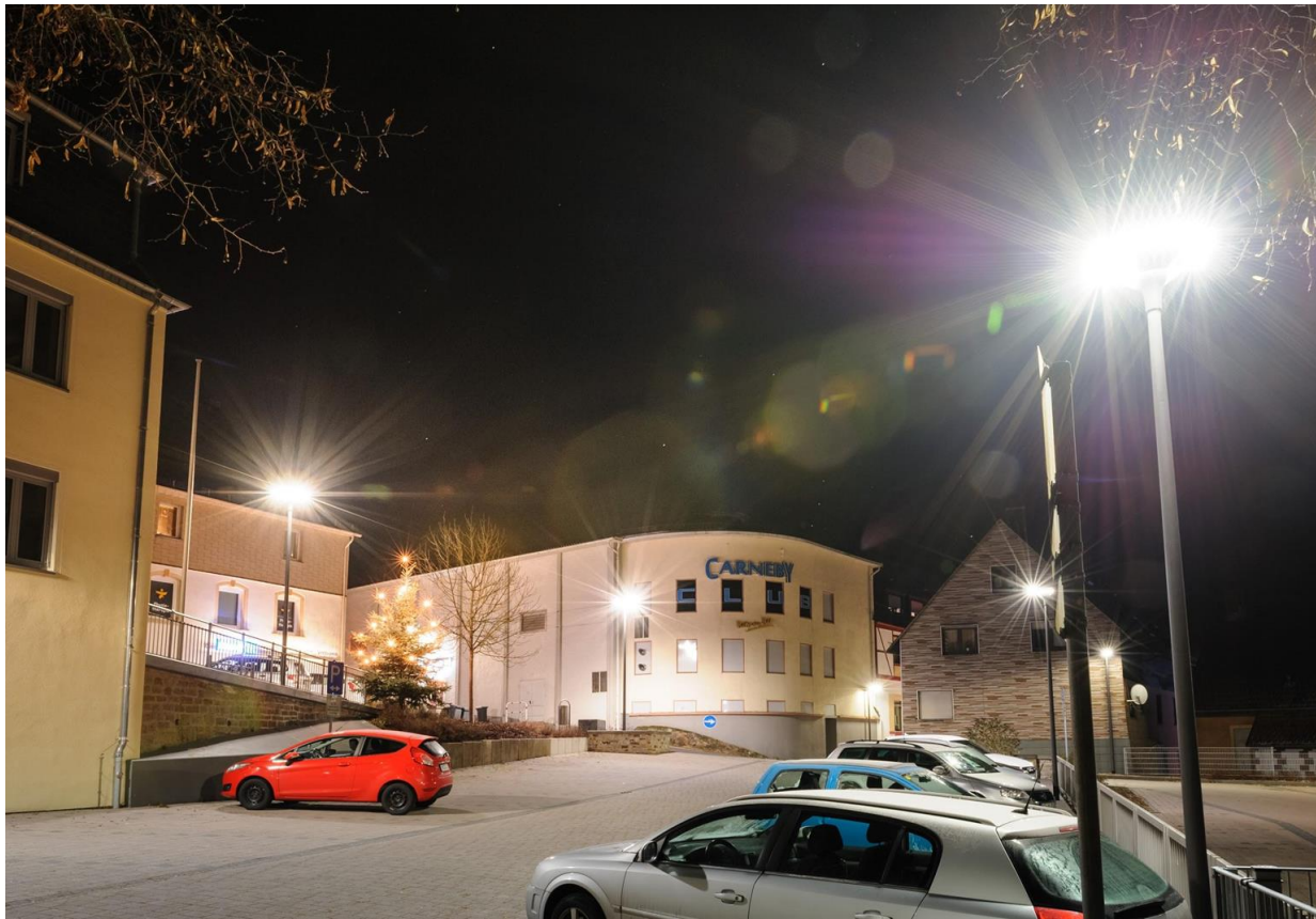
LED Straßenbeleuchtung vor dem Verwaltungsgebäude II in Birkenfeld
