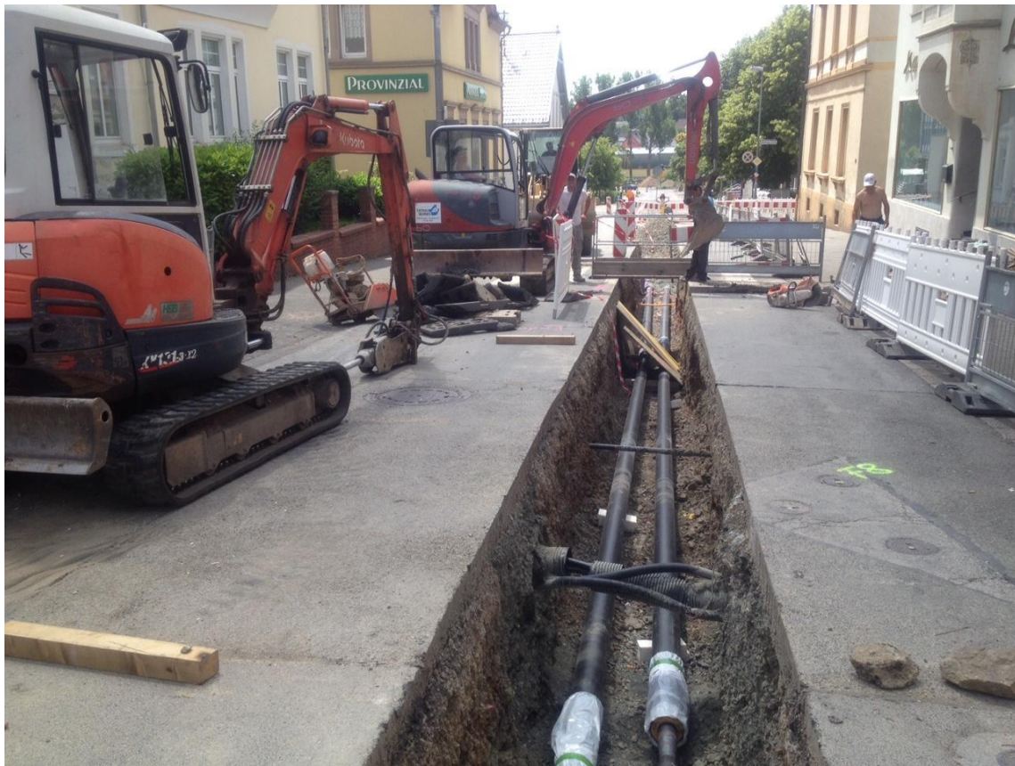
Nahwärmenetz Birkenfeld im Bau
