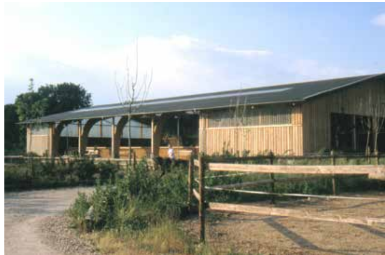
Reithalle mit großen Öffnungen an zwei Seiten
