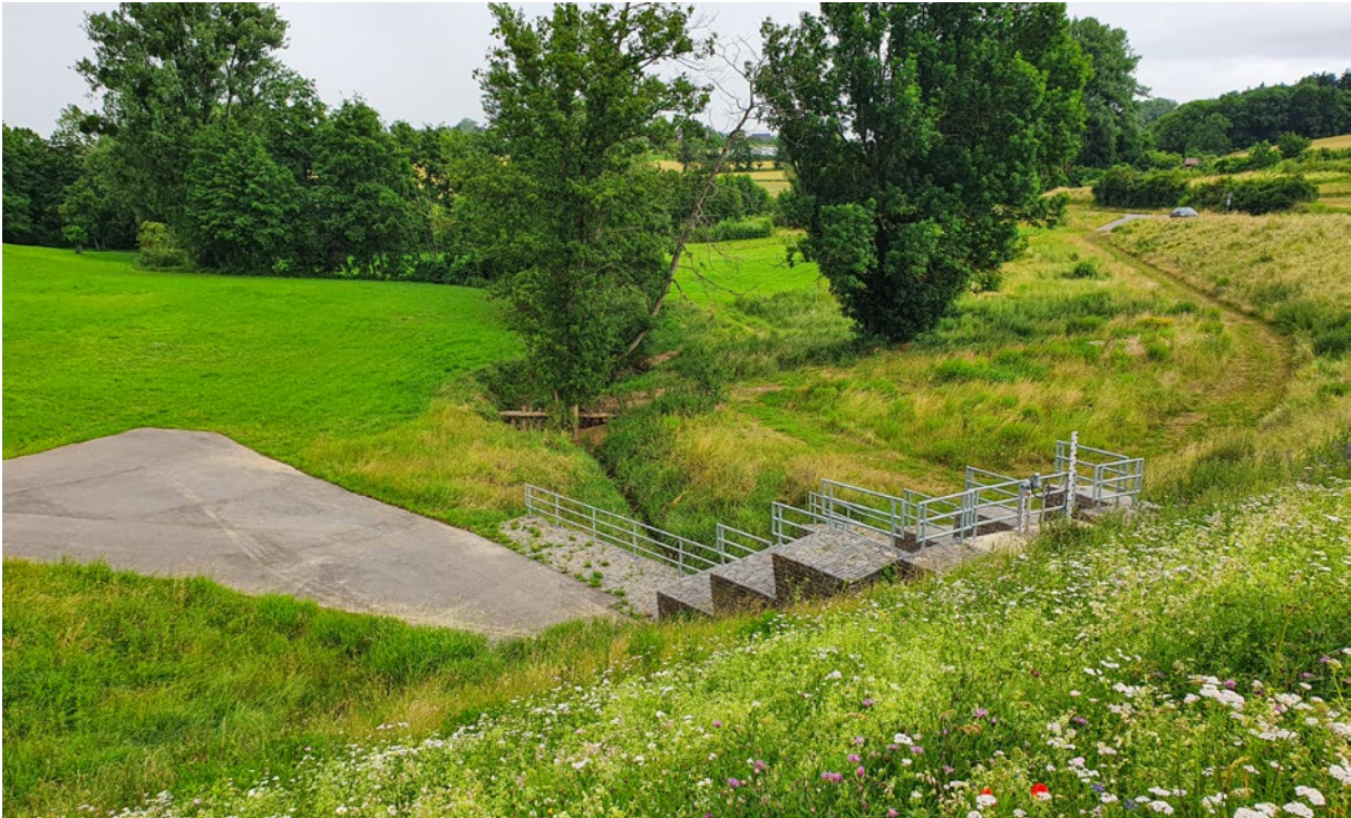
Regenrückhaltebecken alleine sind keine Lösung. Viele Bereiche müssen im Verbund gesehen werden. (Foto: Kirschbauer)
