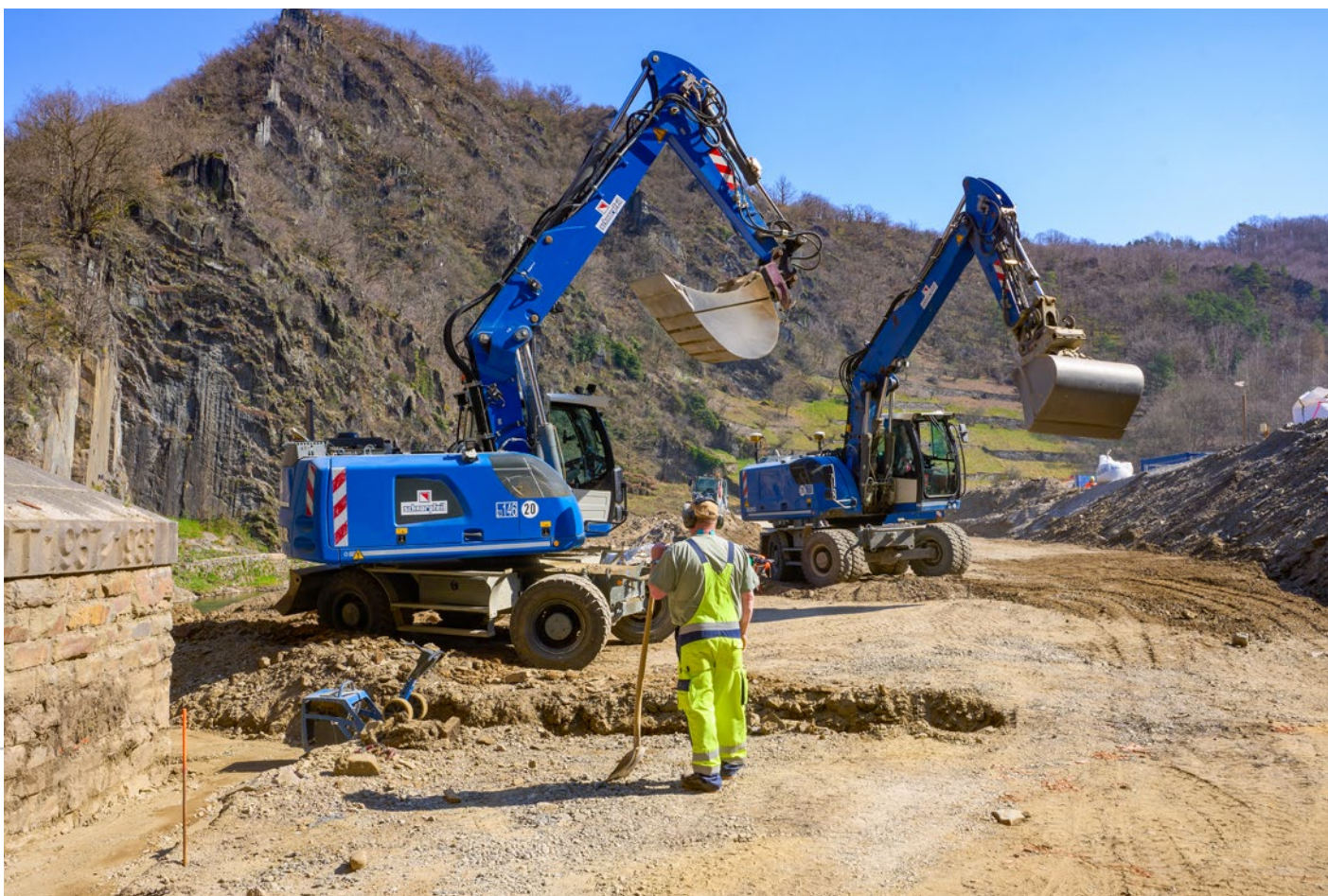
Straßenbauarbeiten an der B 257 bei Altenahr. (Foto: Frey)
