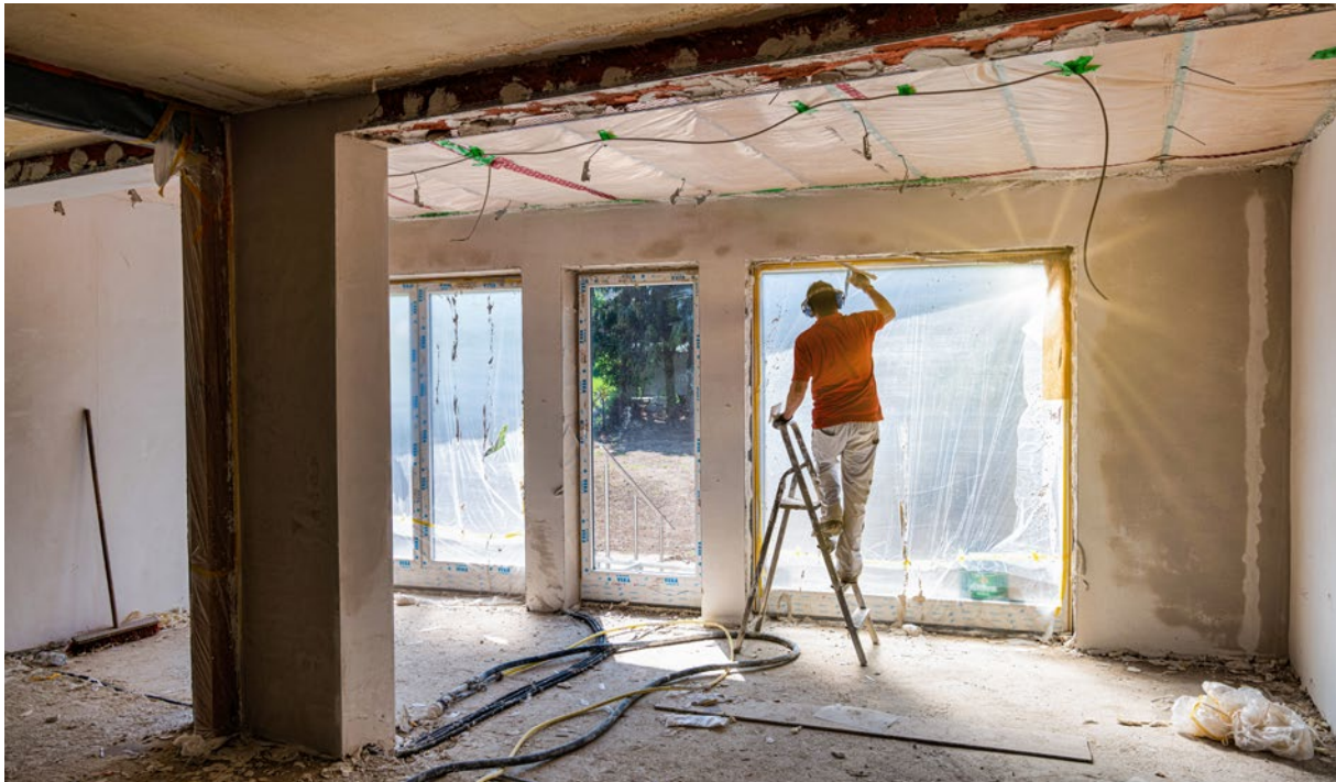
Entkernte Gebäude werden Stück für Stück wieder in einen nutzbaren Zustand versetzt. (Foto: Piel media)
