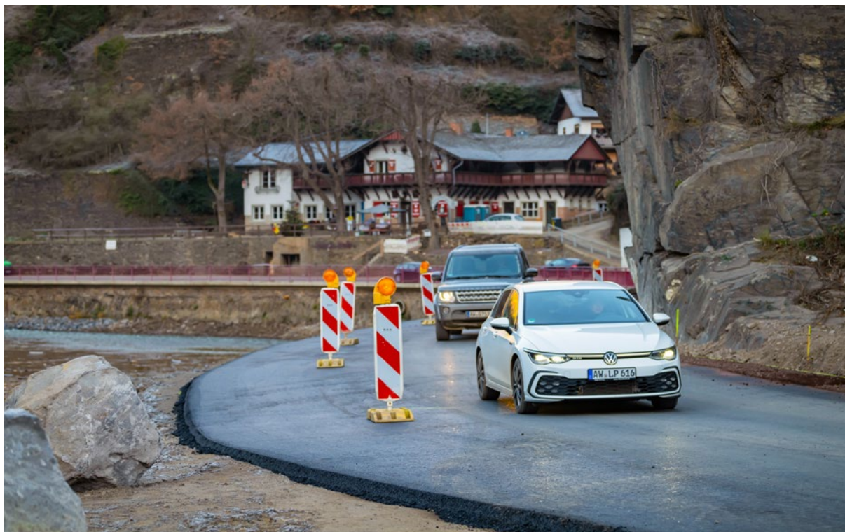
Der Wiederaufbau wird noch Zeit beanspruchen. Bereits vorm Frühjahr 2022 wurde mancherorts die Straße neu asphaltiert. (Foto: Piel media)
