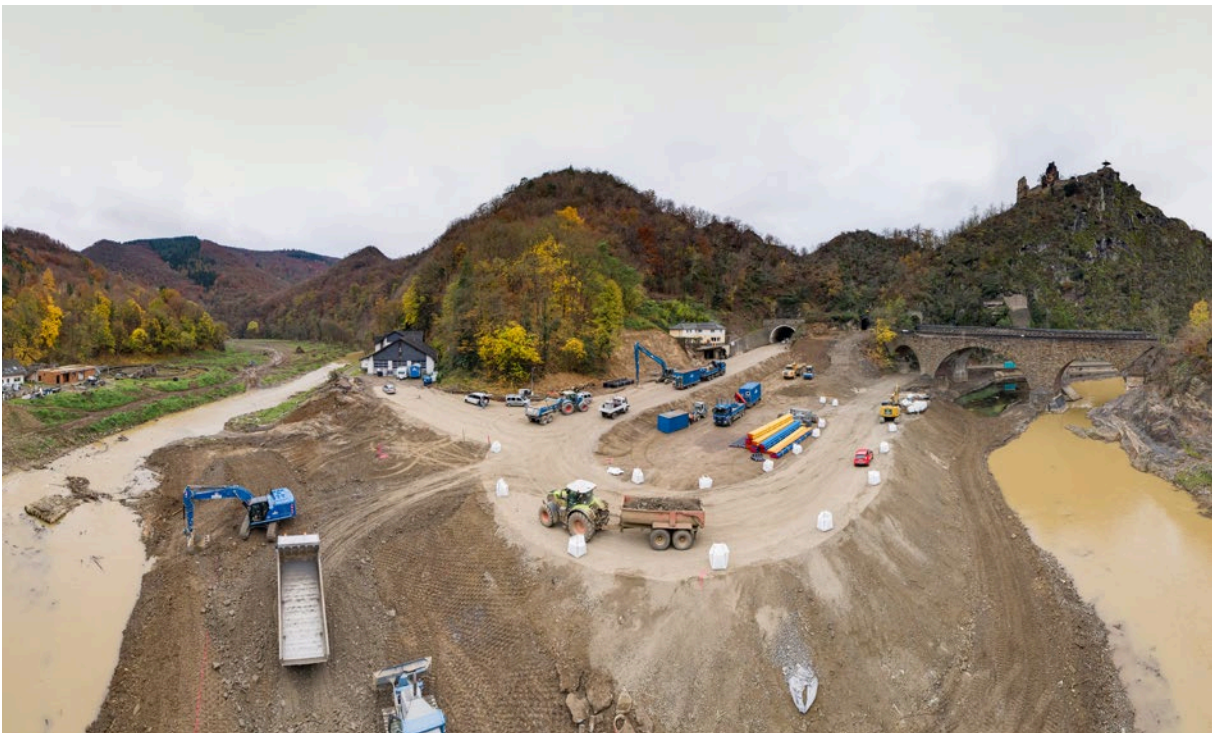
Der Tunnel der B 267 im Frühjahr 2022. Die Bauarbeiten gehen gut voran. Voraussichtlich im Sommer wird die Strecke wieder durchgängig befahrbar sein. (Foto: Frey)
