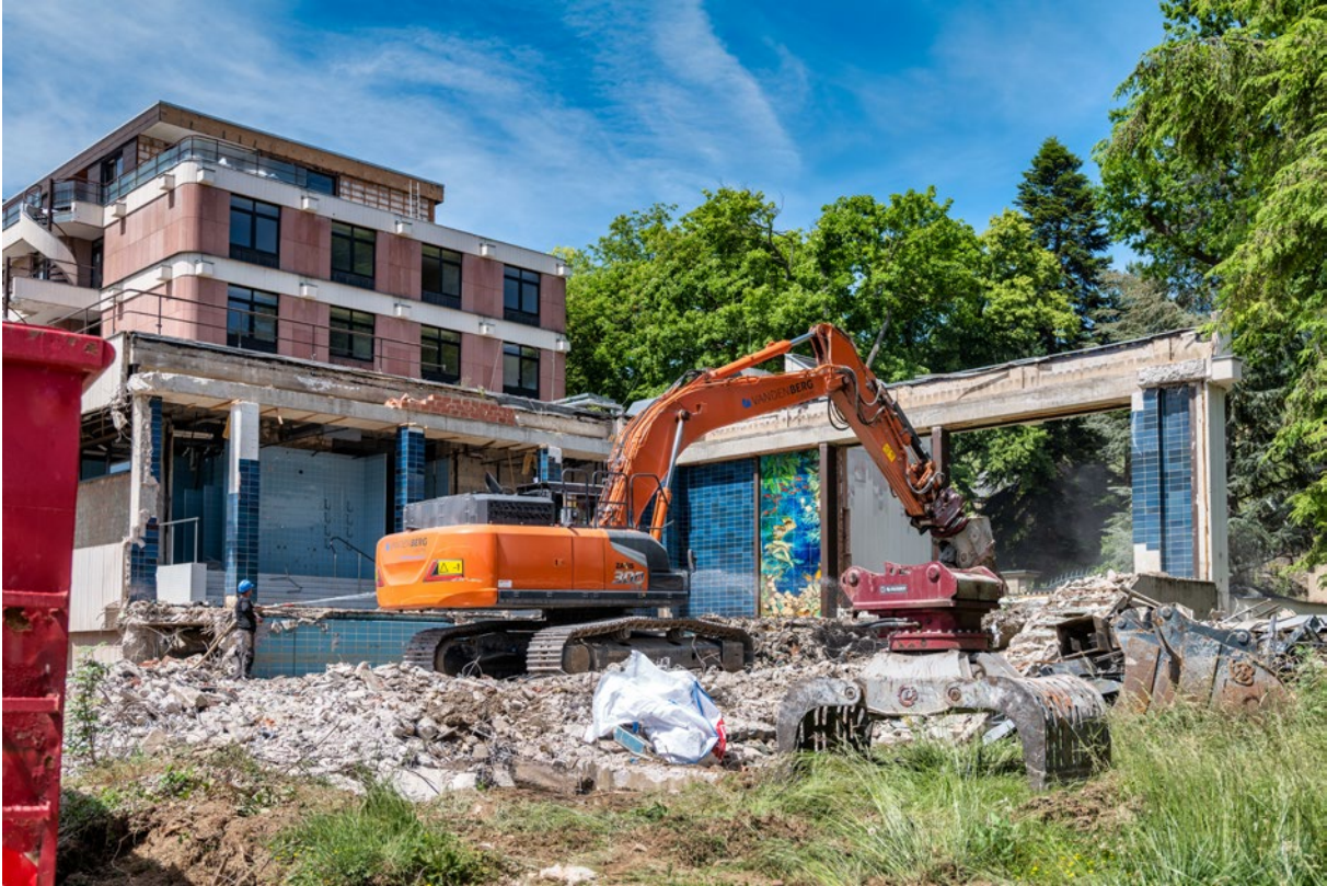
Ein Nebengebäude der Dr. von Ehrenwall'schen Klinik wird abgerissen. (Foto: Piel media)
