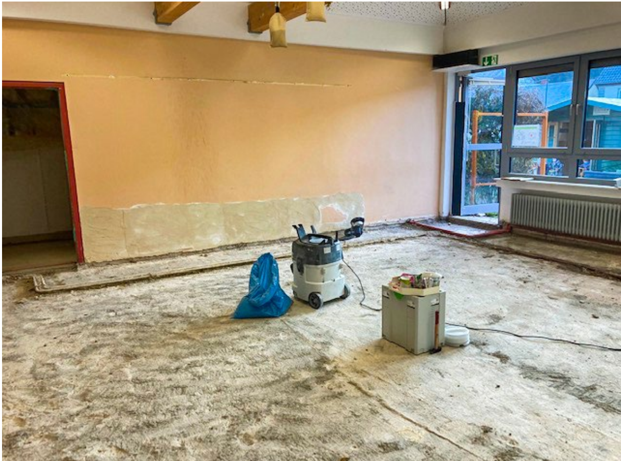
Die Innensanierung ist mittlerweile erfolgt, sodass die Kita wieder genutzt werden kann. (Foto: VG Prüm)
