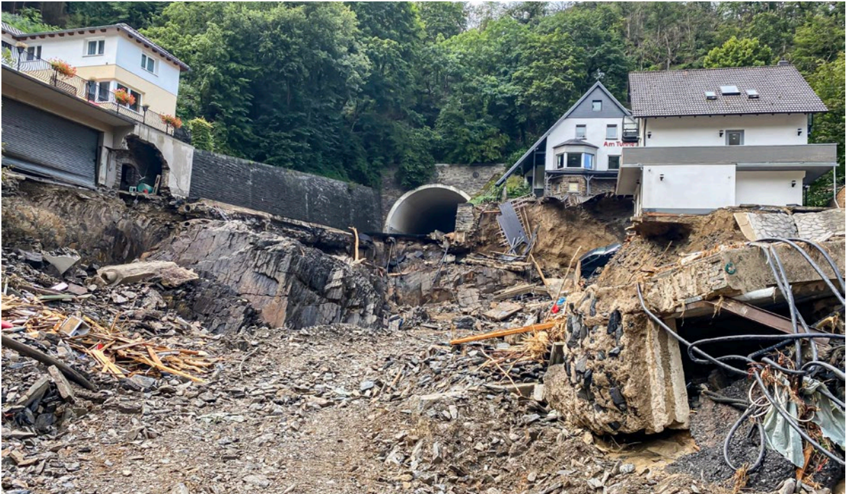
Der Tunnel der B 267 bei Altenahr unmittelbar nach der Naturkatastrophe. (Foto: LBM)
