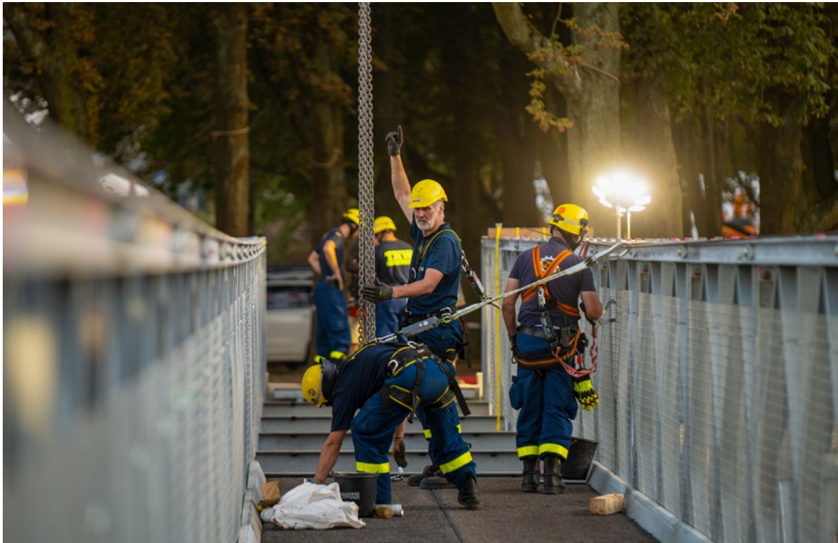
Die Wiederaufbauarbeiten brauchen Zeit. Da wird zum Teil das Tageslicht knapp. (Foto: PlannIng GmbH, Ketz)
