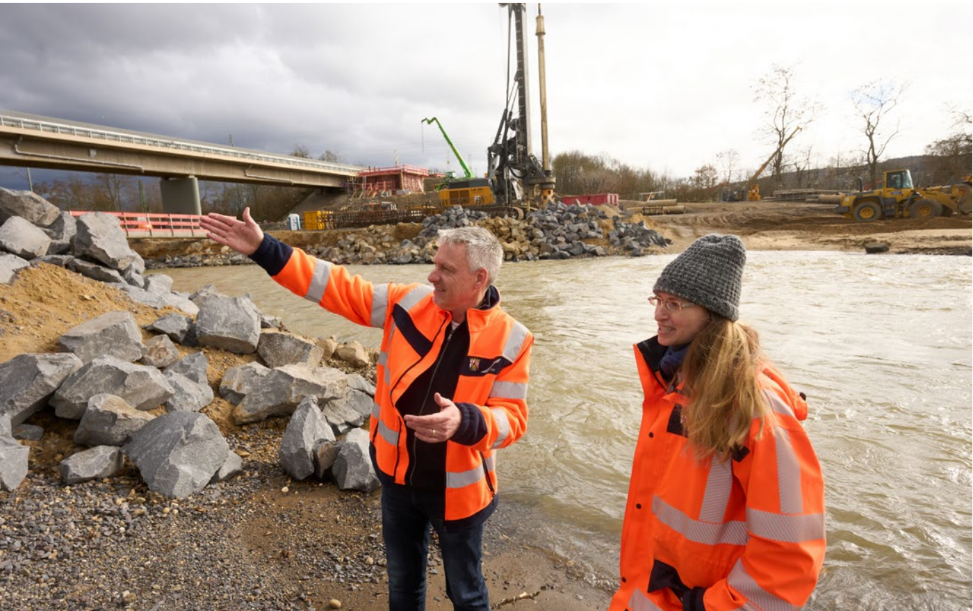
Ein Team des LBM-Projektbüros Ahrtal erkundet die Brückenbaustelle an der B 9. (Foto: Frey)
