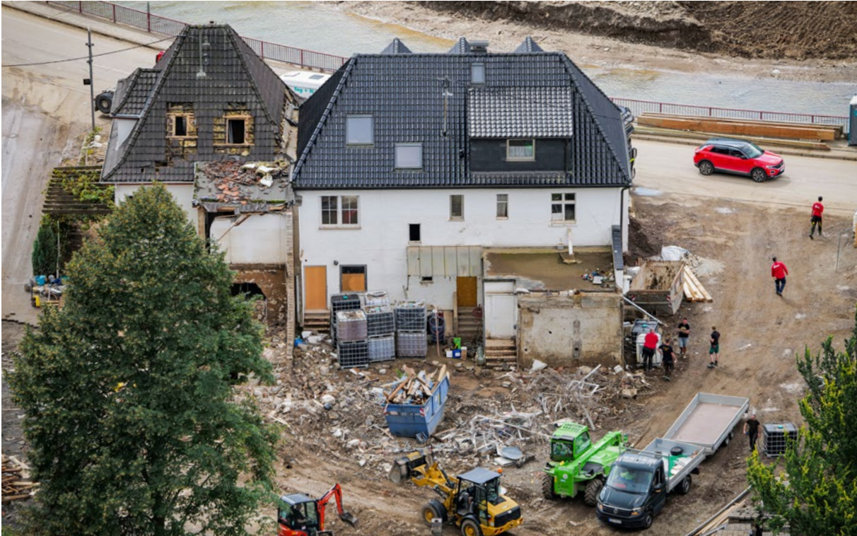
Viele Häuser mussten entkernt, manche abgerissen werden. (Foto: Piel media)
