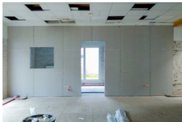
Bei Redaktionsschluss waren im Jugendtreff in Trier-Ehrang bereits neue Trockenbauwände gesetzt, neuer Estrich sollte folgen. (Fotos: Hochbauamt Trier)
