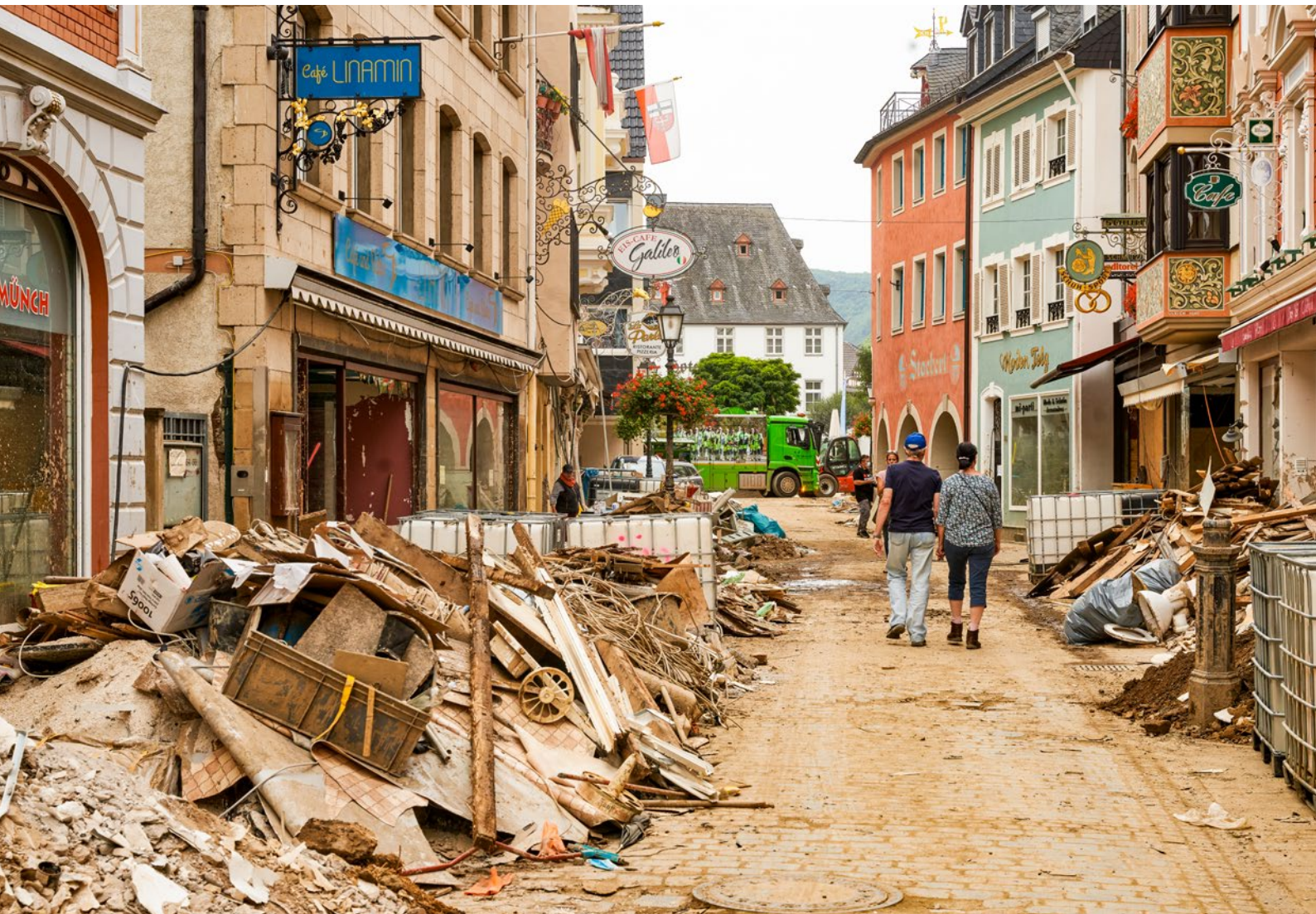
Die Innenstadt von Bad Neuenahr-Ahrweiler nach den ersten Bergungs- und Aufräumarbeiten. (Foto: Frey)
