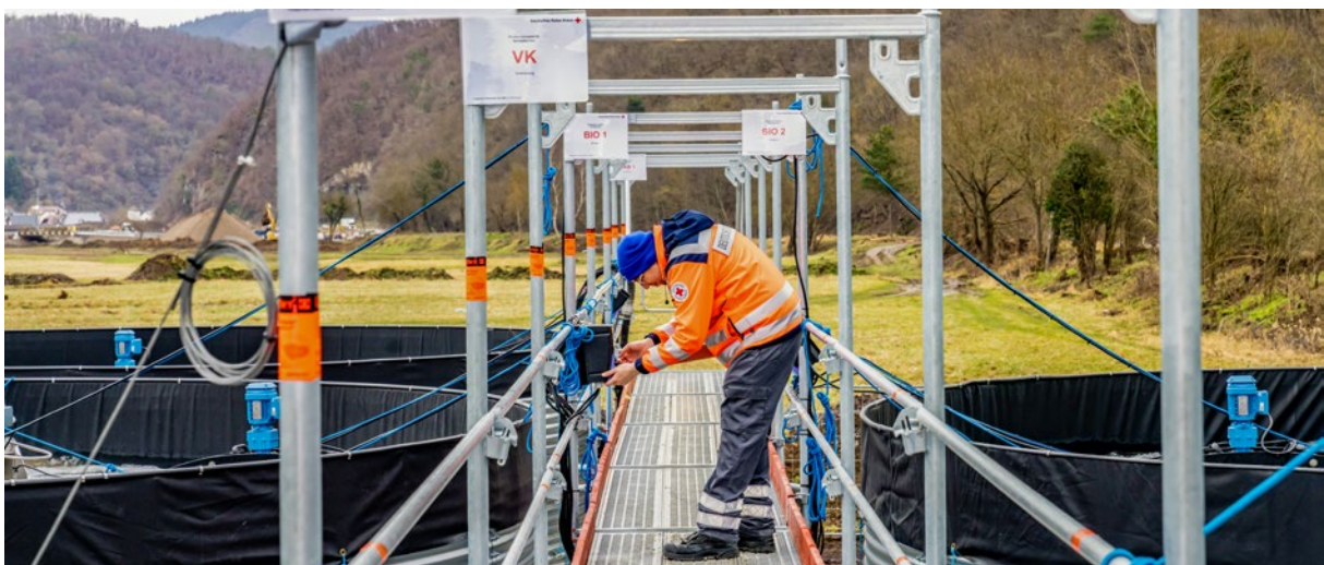
Das ist weltweit einzigartig: Die ganze Anlage kann ohne Großgeräte errichtet werden. (Foto: Köhler/DRK)
