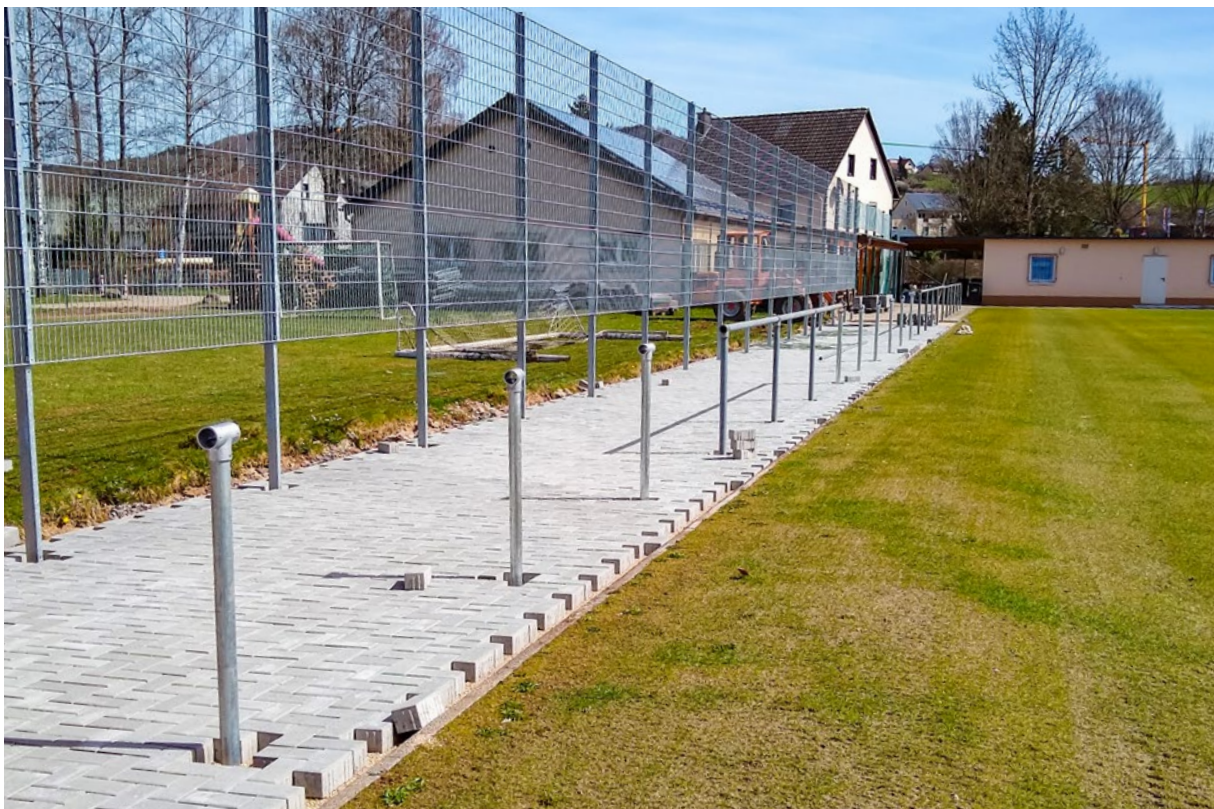
Im April 2022 ist der Zuschauerbereich fast fertig wiederaufgebaut. (Foto: VG Arzfeld)
