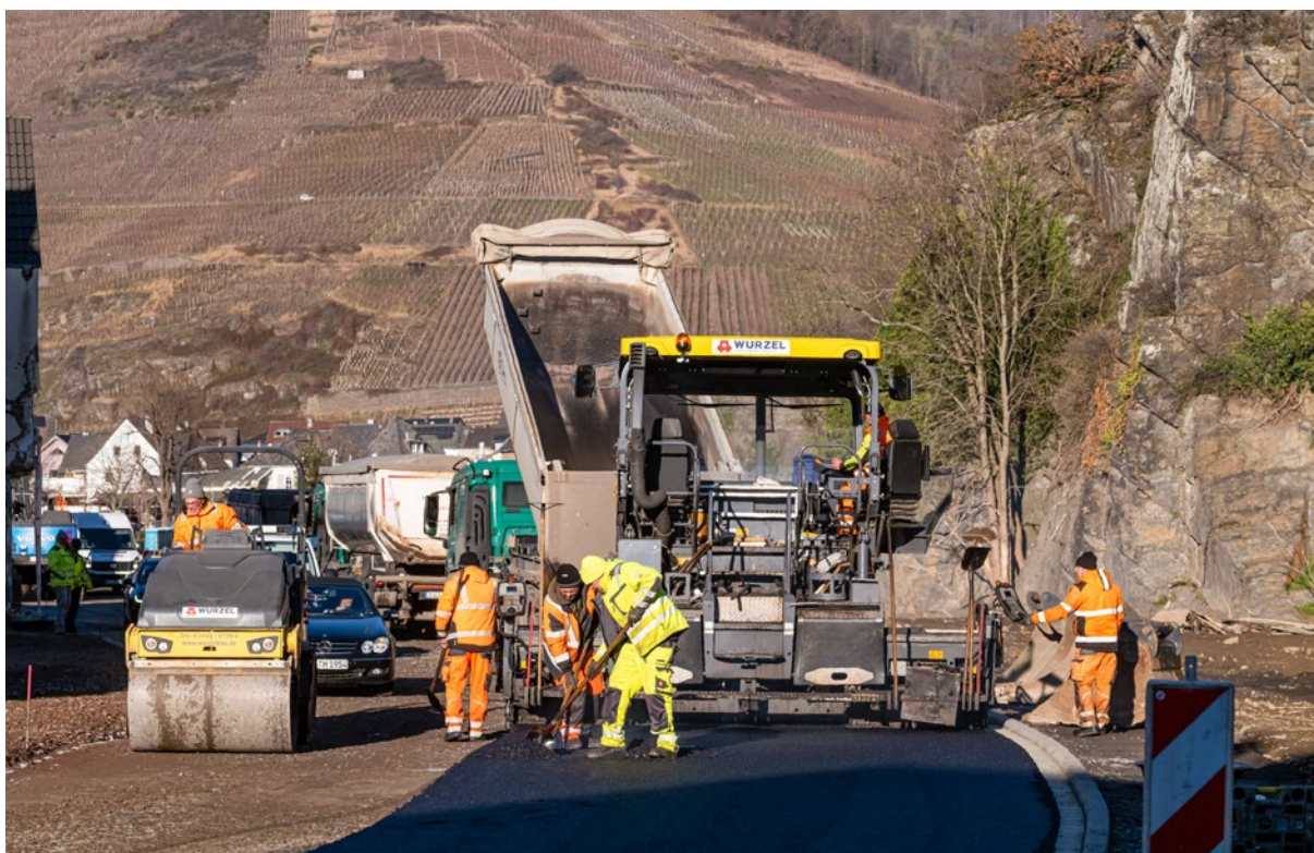
Im engen Tal galt der Wiederherstellung der Straßen ein besonderes Augenmerk. (Foto: Piel media)
