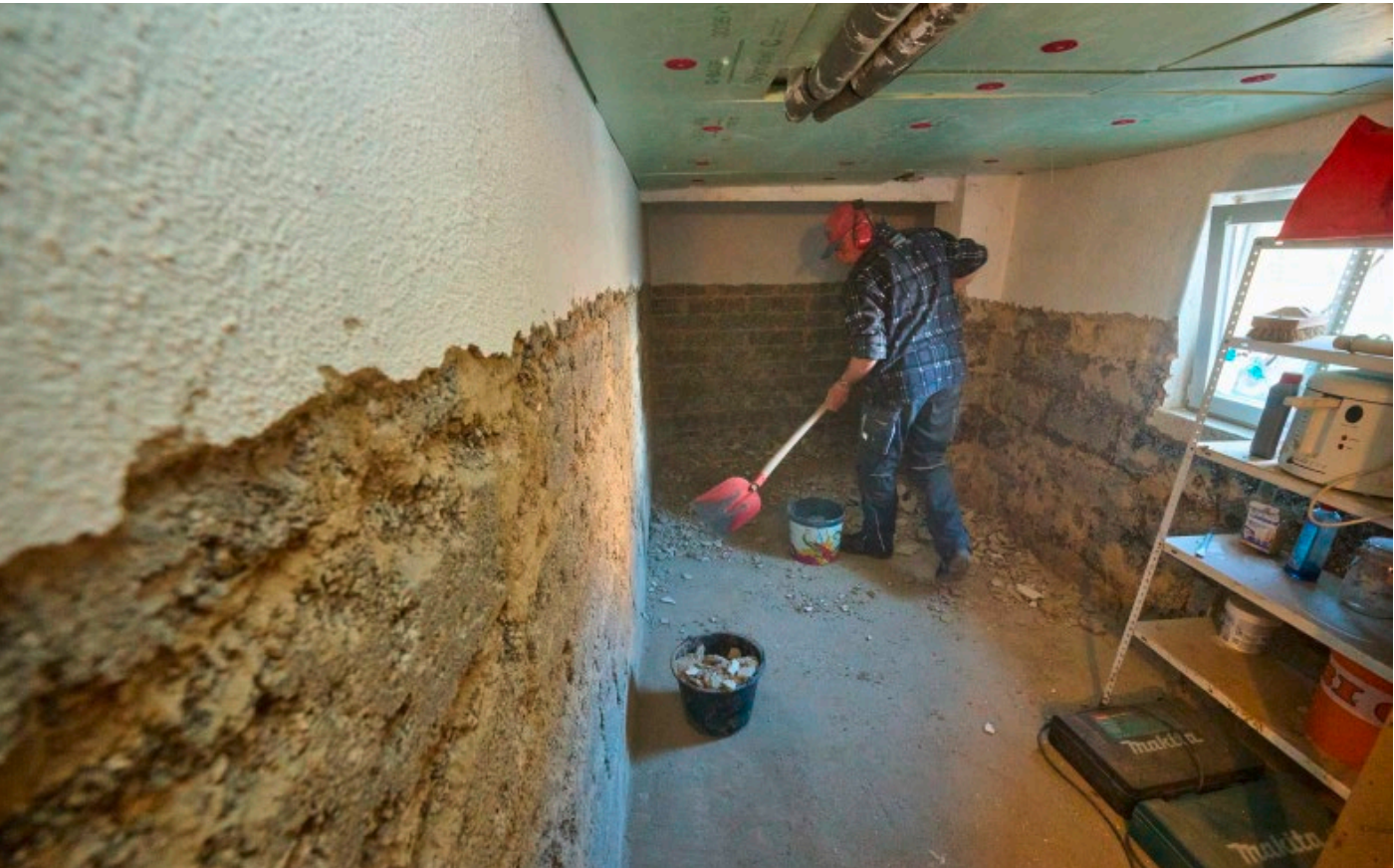
Helfer, die mit dem Helfer-Shuttle angereist waren, schlagen in einem Privathaus in Mayschoß den Putz ab. (Foto: Frey)
