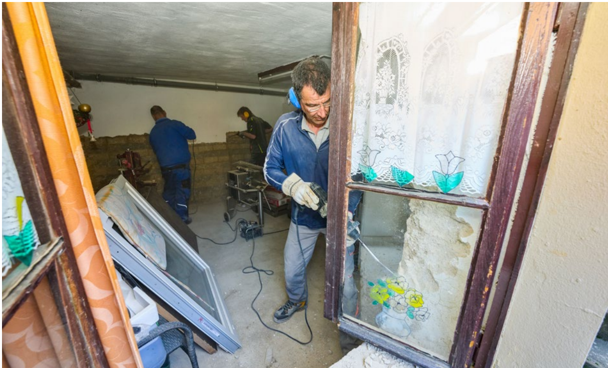
Wände stemmen, Fenster austauschen: Vielfach übernahmen Helfende Handwerkerarbeiten. (Foto: Frey)
