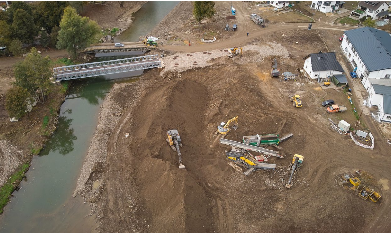
Neben dem Bau von Behelfsbrücken stand auch der Abtransport von Abfällen und Schutt an. (Foto: Frey)
