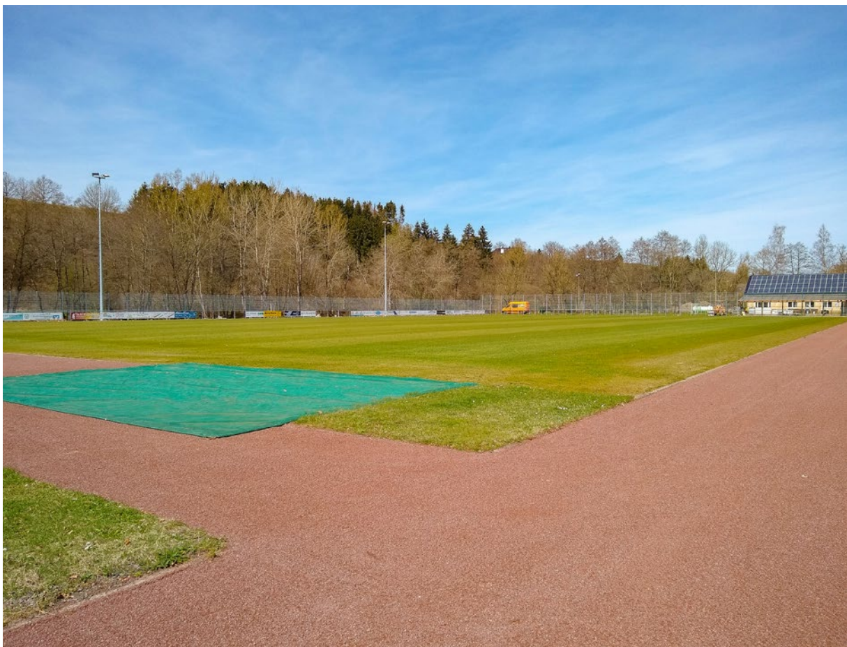
Der Sportplatz Lünebach nach dem Wiederaufbau. (Foto: VG Arzfeld)
