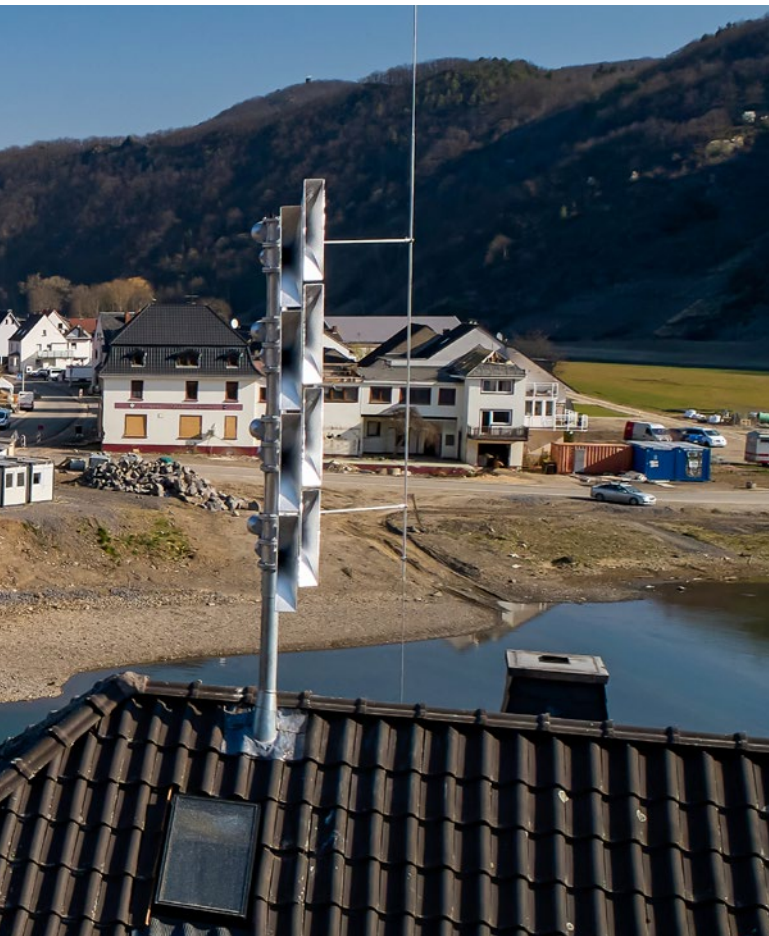
Die neue Warnanlage auf dem Dach (im Bild rechts) kann weit mehr als die vertrauten Sirenenanlagen. Sie kann Sprachmeldungen aller Art übertragen, um die Bevölkerung gezielt und differenziert zu informieren. (Foto: Frey)
