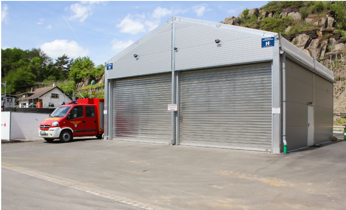
Auch Feuerwehrhäuser wurden durch die Fluten beschädigt, so dass Ersatzbauten nötig wurden. (Foto: Adams)
