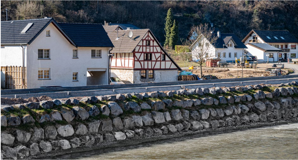
Deutlich ertüchtigte Uferbefestigungen sollen eine weitere Katastrophe verhindern. (Foto: Piel media)
