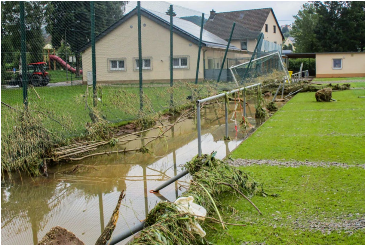
Der Zuschauerbereich des Sportplatzes Lünebach wurde vollkommen zerstört. (Foto: VG Arzfeld)
