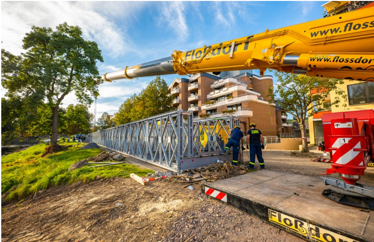
Beim Bau der Brücken kommt schweres Gerät zum Einsatz. (Foto: PlannIng GmbH, Ketz)
