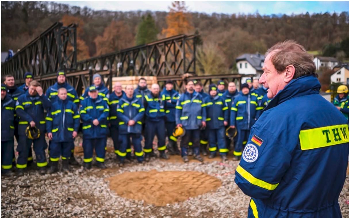
Die Brücke in Müsch war die zwanzigste Behelfsbrücken des THW im Ahrtal. (Foto: Hohmann/THW)
