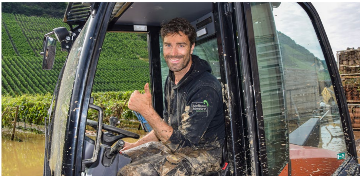
Es geht voran auf Deutschlands größter Wiederaufbaustelle. Handwerkerinnen und Handwerker aus ganz Deutschland helfen dabei. (Foto: HwK Koblenz)
