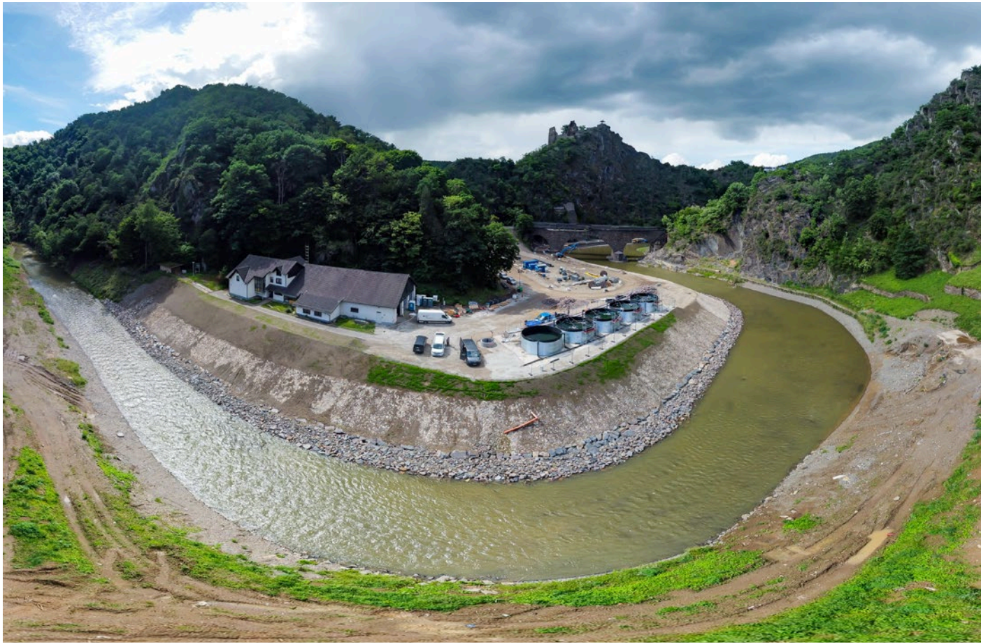
Die Behelfskläranlage in Altenahr liegt deutlich höher als die zerstörte Kläranlage. (Foto: Frey)
