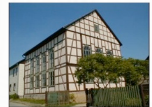
Die Berkacher Synagoge vor der Restaurierung der Fassade
