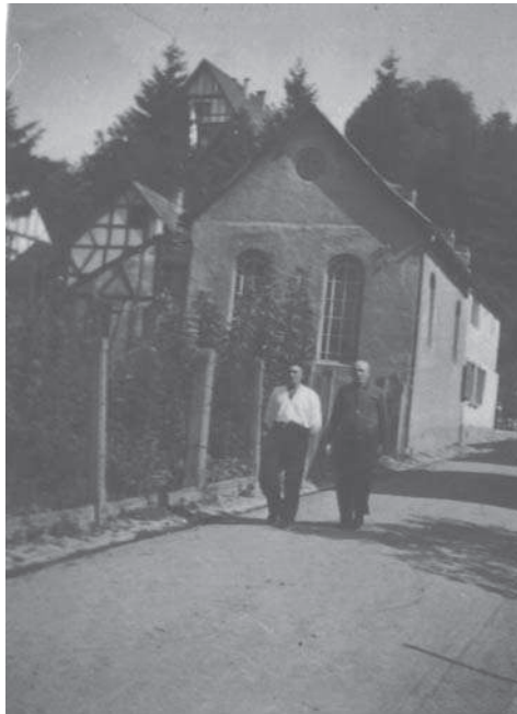
Die ehemalige Synagoge in der Bergstraße dahinter das Eckhaus zur Straße zum Aubachtal
