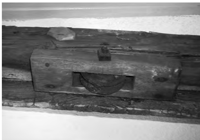
Als Laufräder dienen kleine Rollen, die ursprünglich zur Führung von Seilzügen angefertigt wurden (Foto: Hans-Christof Haas)
