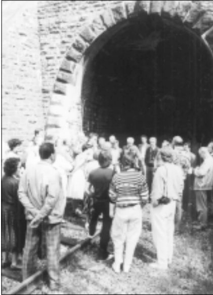
Der Hasselborner Tunnel auf Grävenwiesbacher Seite
