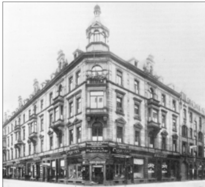
Altes Gewerkschaftshaus in der Frankfurter Allerheiligengasse 21-25. Dieses sowie auch das 1931 neu erbaute Gewerkschaftshaus wurden am 2. Mai 1933 von den Nazis besetzt.
