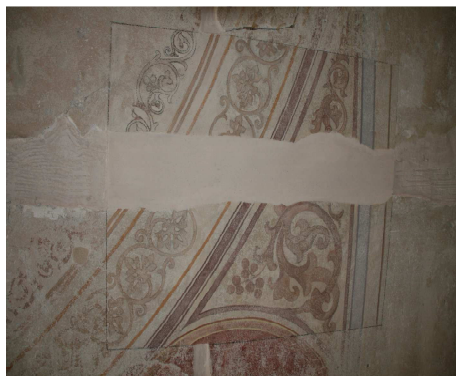
restauriertes Musterstück der Decke
