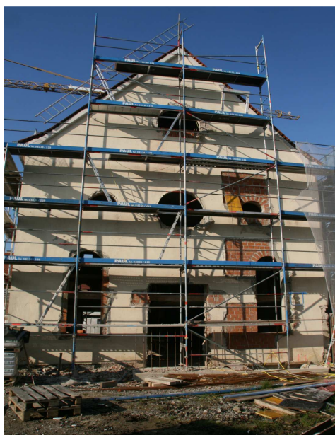
Außenansicht, Ostseite (Oktober 2014)
