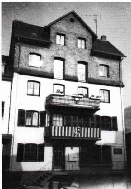
Synagoge Oberwesel, zum Wohnhaus umgebaut, 1992
