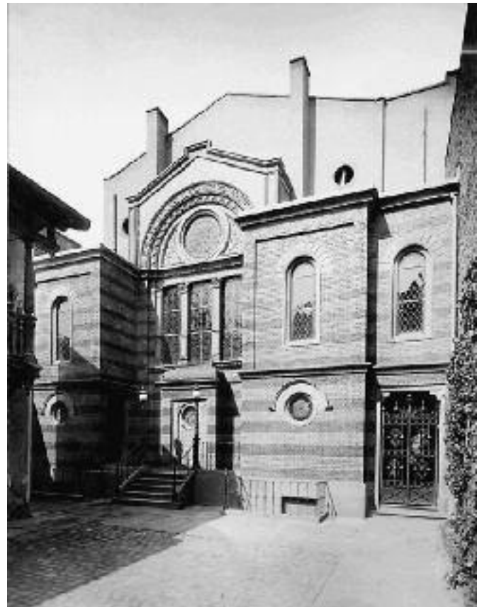
Abbildung 2: Ostfassade mit Haupteingang der Orthodoxen Synagoge in der Karl-Friedrich-Straße in Karlsruhe. Die Synagoge, erbaut von Gustav Ziegler, wurde 1881 eingeweiht.
