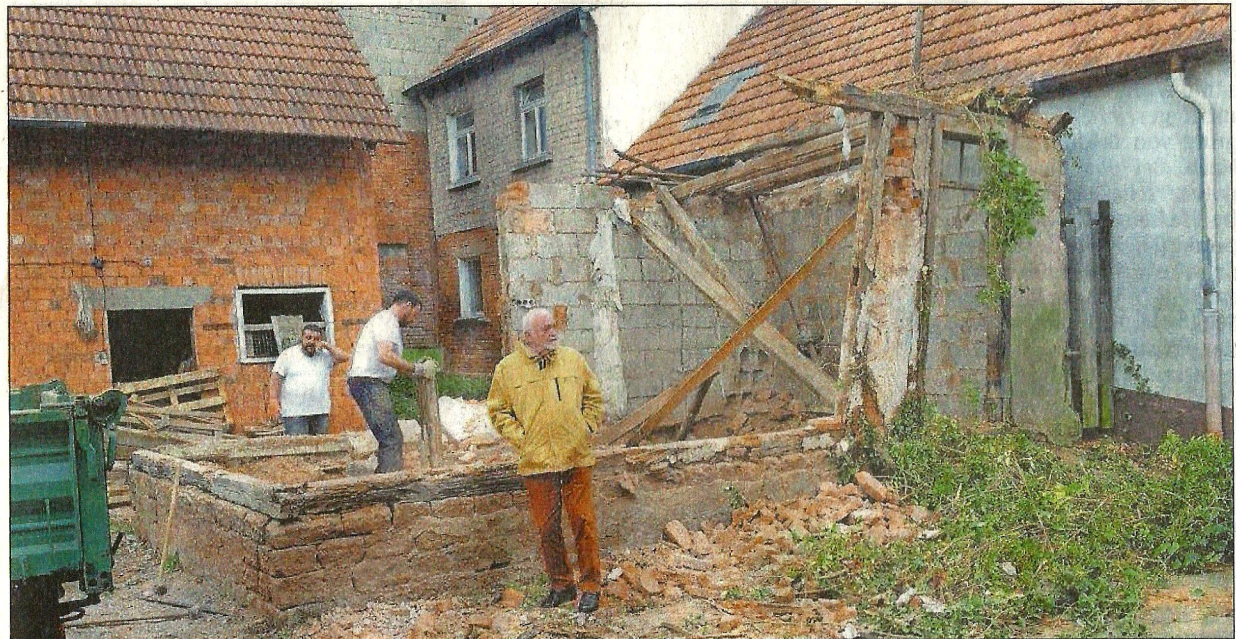
Heimatforscher Otmar Weber vor den Resten des alten Mikwe-Hauses.
