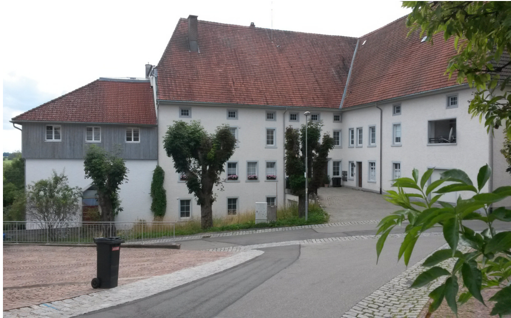
Schloßstraße 5A. Der kleine Anbau links ist die als solche bezeichnete Synagoge. „die nach vorliegenden Akten 1873 an das ehemalige Verwaltungsgebäude Schloß Bonndorf angegliedert wurde.
