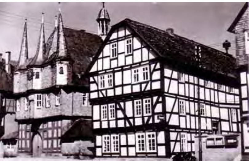
Das ehemalige Dilloff'sche Haus nach dem Umbau zu einem Bürogebäude der Stadtverwaltung, um 1950 (Stadtarchiv Franckenberg)
