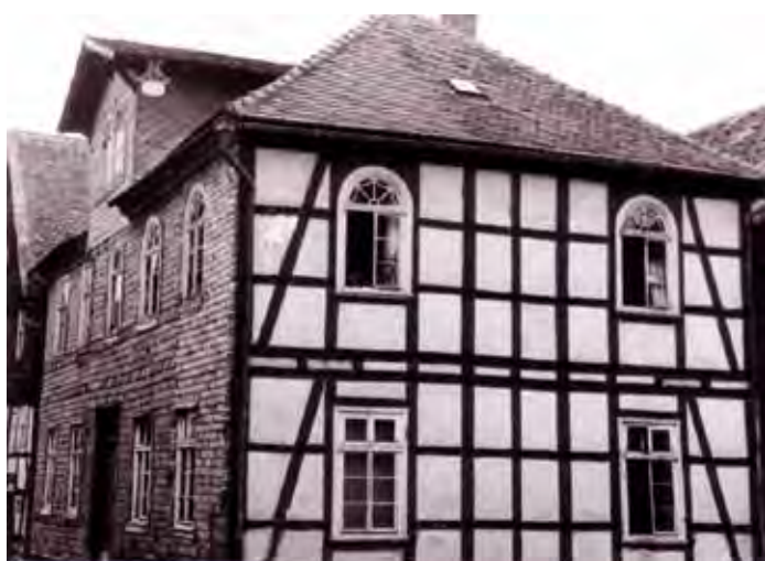
Zustand der ehemaligen Synagoge im Jahr 1950 (Stadtbauamt Frankenberg)
