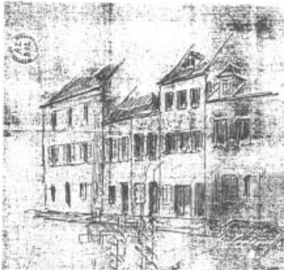
Die alte Synagoge an der Ecke Waffenstraße/Gymnasiumstrasse (Quelle: Arnold, H.: Jüdisches Leben in der Stadt Landau und der Südpfalz , S. 13)
