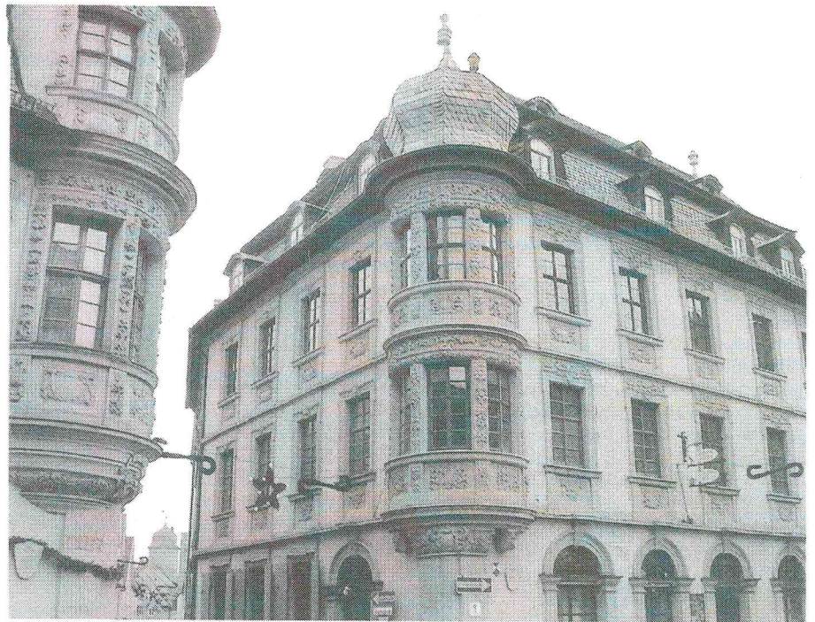
Das 1718 erbaute Wertheimersche Wohn- und Geschäftshaus in Marktbreit.
